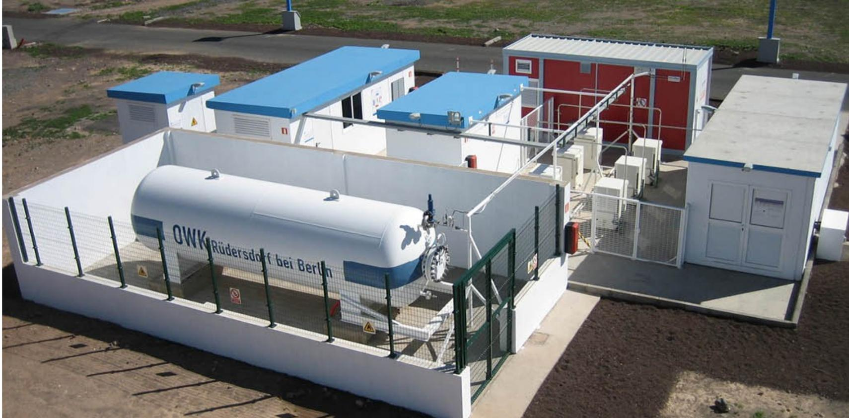
Premier système de production d'hydrogène alimenté par des énergies renouvelables. Premier micro réseau isolé en Espagne, avec stockage d'énergie en H2 (Projet RES2H2)
