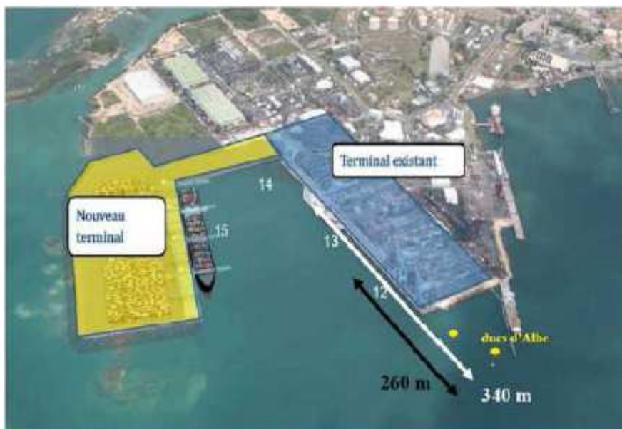
Le terminal de Jarry à l'issue de la deuxième tranche
