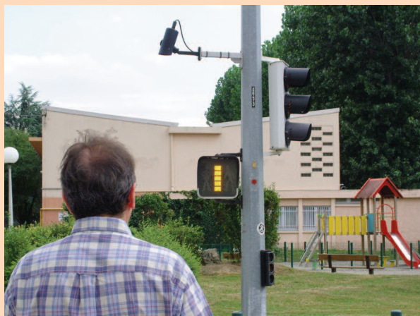
Piéton détecté et passage du signal R12 pps au jaune clignotant
