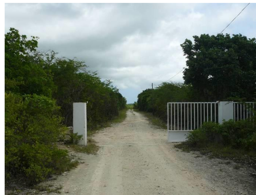
Figure 29 : Voie d'accès et entrée de la centrale éolienne de Fonds Caraïbes
