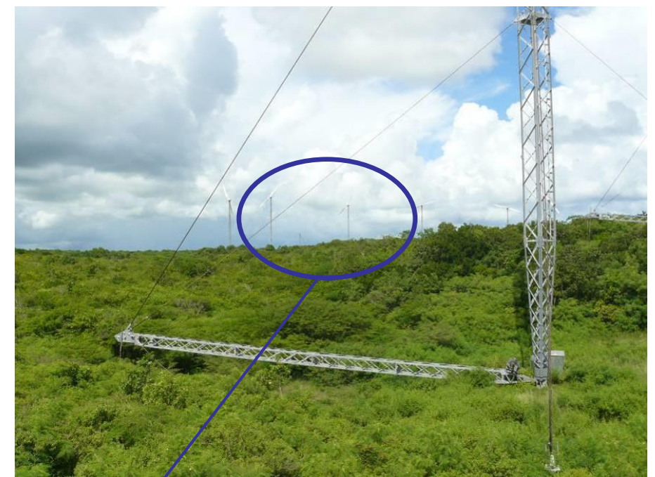
Figure 72 : Vue orientée vers l'éolienne au sol – distance de 700 m
