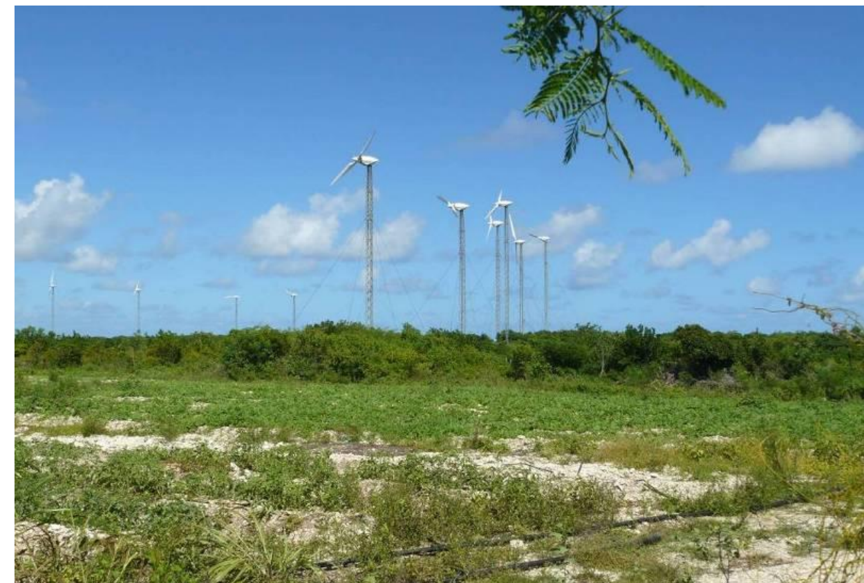
Figure 57 : L'effet de masque de la végétation pour les installations au sol de la centrale éolienne
