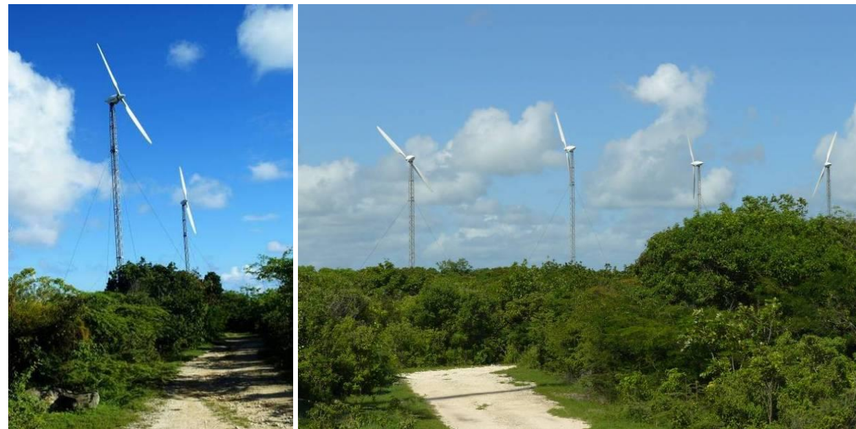
Figure 56 : Circulation au sein de la centrale éolienne
