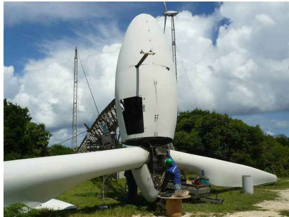
Figure 70 : Maintenance de l'éolienne la plus proche du local technique
