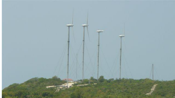
Figure 17 - Centrale éolienne de Désirade 4 (Le Souffleur)
