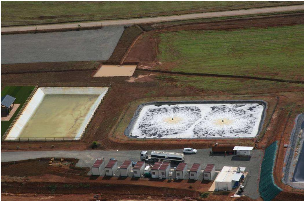
**Figure 50. Vue d'ensemble de l'installation de traitement des lixiviats et ses bassins de prétraitement et stockage**
