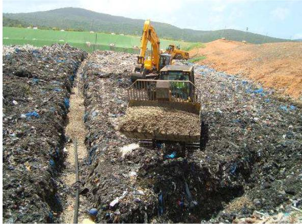
**Figure 64. Réalisation artères pour un meilleur captage du biogaz.**
