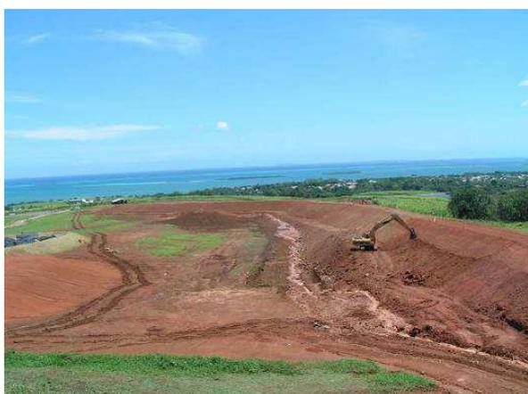
**Figure 74. 7/4/11 Talutage intérieur de la digue périphérique**
