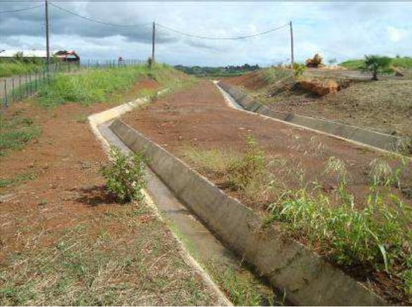
**Figure 56. Fossés béton zone nord. A gauche fossé des eaux de voirie à droite fossé eaux de ruissèlement.**
