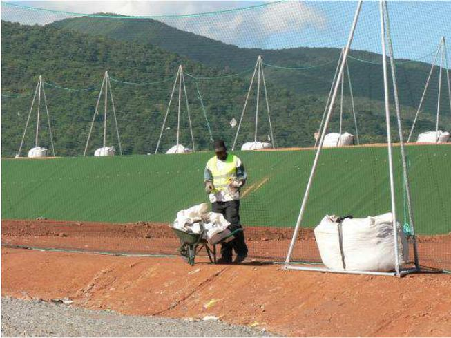
**Figure 24. Opération de ramassage des envols**
