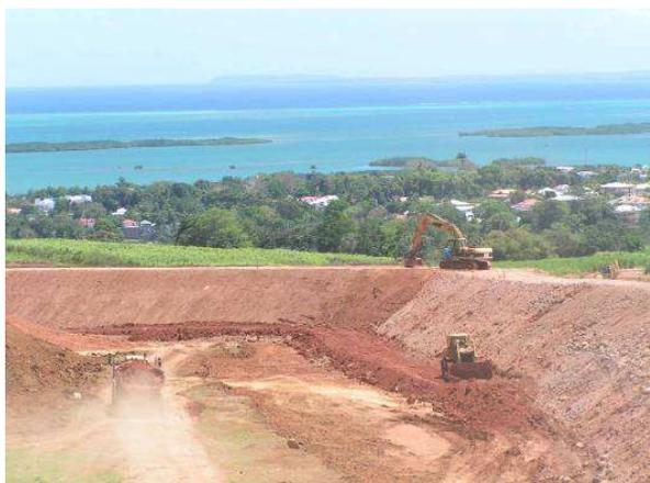
**Figure 72. 31/3/11 Taillage intérieur digue EST**
