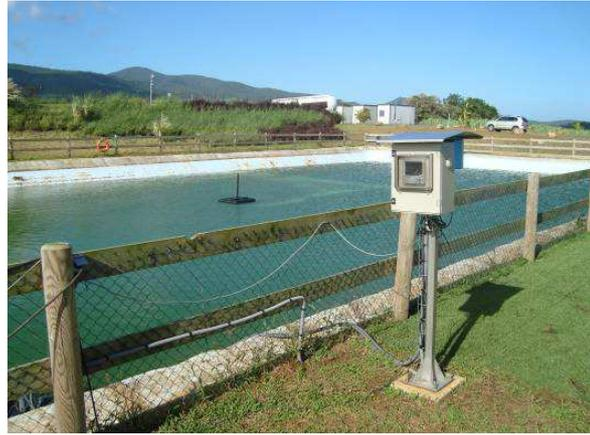
**Figure 47. Appareil de contrôle en continu bassin eaux osmosées.**
