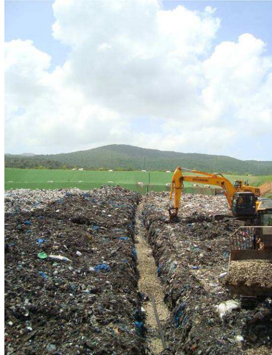
**Figure 65. Mise en place d'un drain biogaz dans l'alvéole A2 (4/10/11)**
