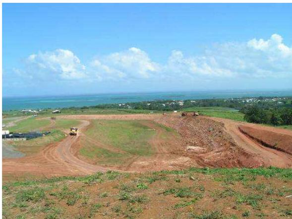
**Figure 71. 10/02/11 Montage et prolongation de la digue périphérique en bordure Est du site**
