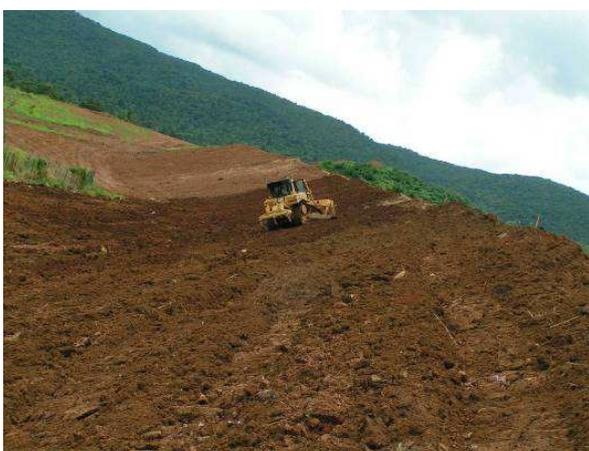
**Figure 75. 09/09/11 Mise en place de terre végétale en finition**
