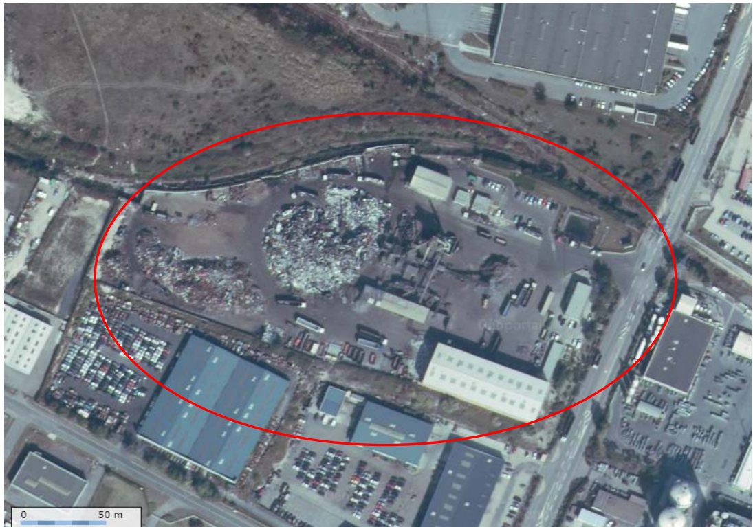
Figure 47 : Vue aérienne de l'installation de GDE à Limay (source : Geoportail.fr)
