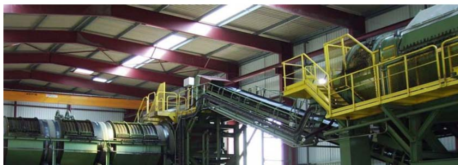
Figure 51 : Photos illustrant les installations de traitement des RBA par GDE (Source : gderecyclage.com)
