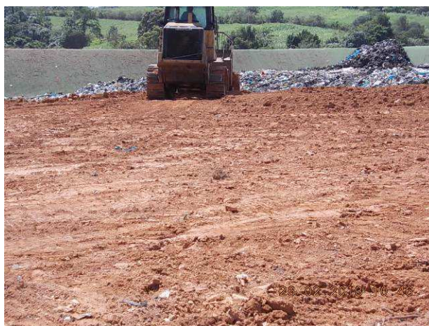
Figure 17 - Aménagement d'une couverture provisoire
