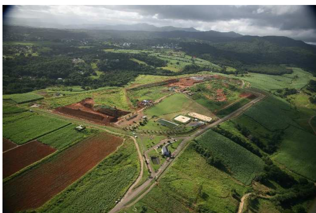
Figure 21 - Vue générale nord
