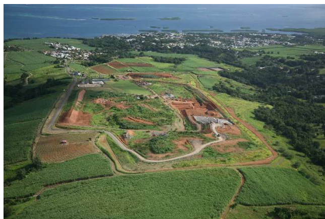
Figure 22 - Vue générale sud
