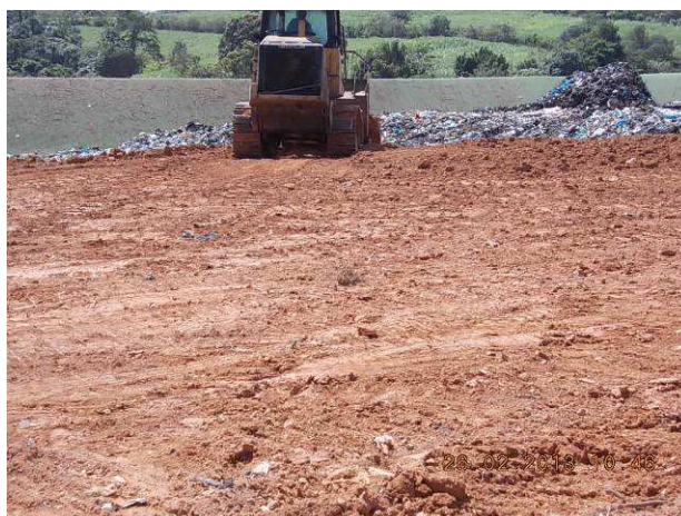
Figure 17 - Aménagement d'une couverture provisoire
