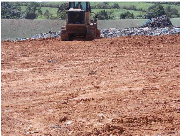
*Figure 23 - Aménagement d'une couverture provisoire*
