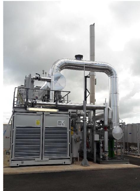
Figure 13 - Vue de détail de la plateforme de valorisation biogaz
