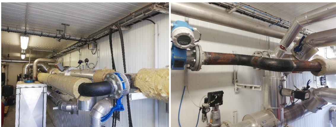
Figure 6 : Modification de la tuyauterie interne au process de la TAR
