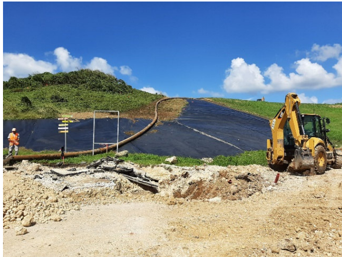
Figure 13 : dévoiement du collecteur principal de biogaz
