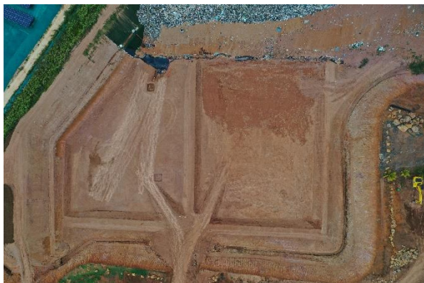
Figure 25 - Travaux alvéoles K2 et J2
