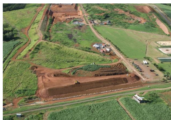
Figure 30 - Vue aérienne merlon paysager
