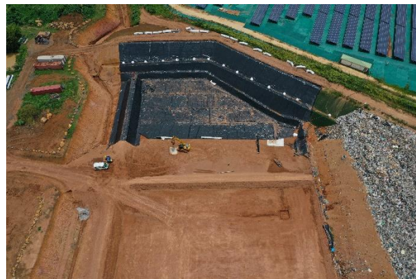
Figure 26 – Travaux d'étanchéité sur K2
