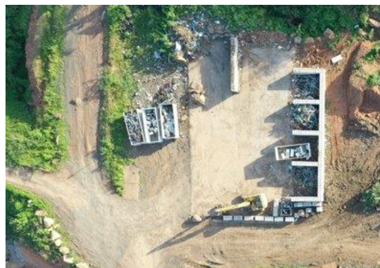
Figure 2 : Vue aérienne de la plateforme de tri
