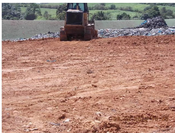
Figure 27 - Aménagement d'une couverture provisoire
