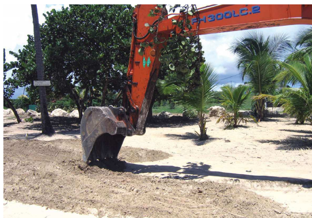
Bois Jolan - Décompactage fond de forme à l'aide d'une pelle mécanique. (Photo ONF Guadeloupe)
