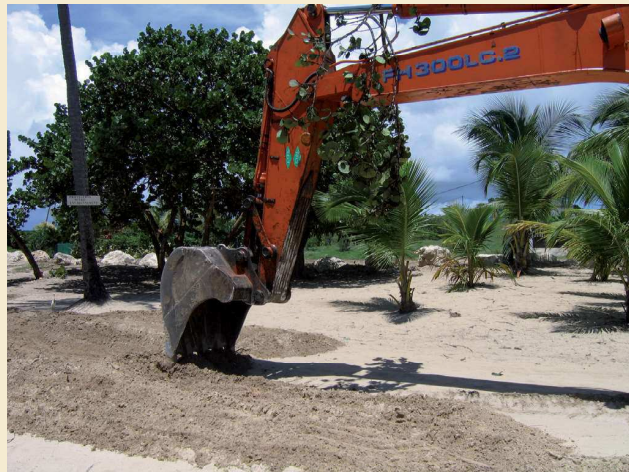
Décompactage fond de forme à l'aide d'une pelle mécanique
