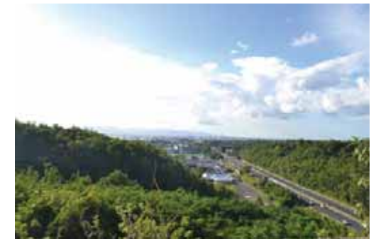
N4 – vue depuis Fort Fleur d'Épée en direction de Pointe-à-Pitre – coupure visible de la 2x2 voies
