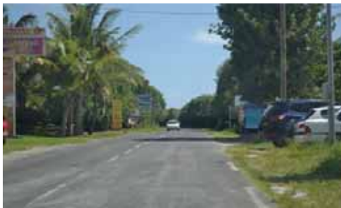
N4 – entre Ste Anne et St François – large emprise et absence de cheminement doux
