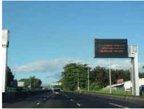
Panneau à message variable sur la 2x2 voies
