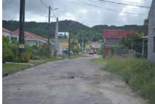
Saint Louis, voie résidentielle en mauvais état
