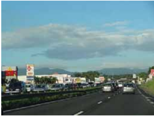
Traversée de Jarry par la 2x2 voies
