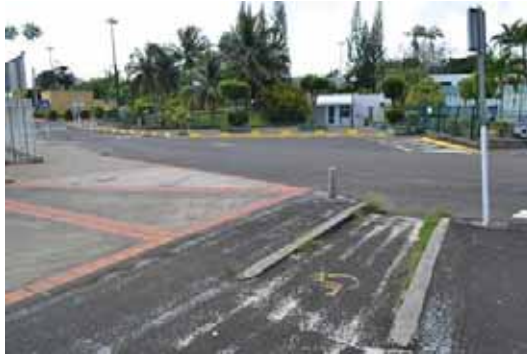
Collège Lamentin : accès handicapés, larges trottoirs, ralentisseurs et arrêts de bus
