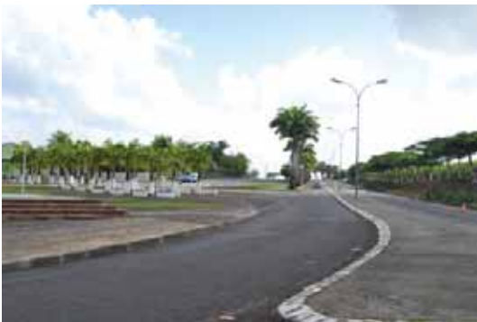
Lycée polyvalent de Baie-Mahault : voie d'accès en faveur de la mixité d'usage, avec des ralentisseurs
