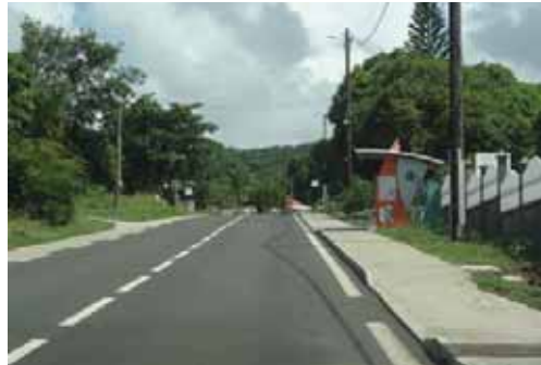
N2 - entre Baille Argent et Deshaies – aménagement récent avec trottoir et accotement de couleur
