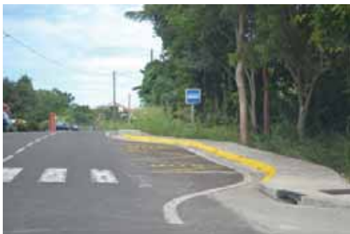
N9 entre Capesterre et Grand Bourg – aménagement récent de qualité avec nombreux arrêts de bus
