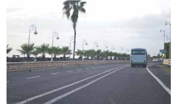
N2 Basse-Terre - promenade piétonne sur les quais et large emprise
