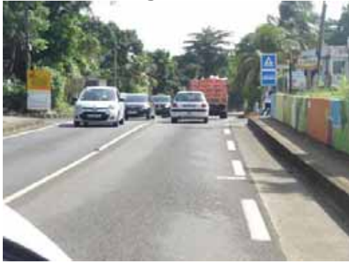
N1 - Entre Baie Mahault et Goyave : des sections étroites de bandes multifonctionnelles ou bandes cyclables
