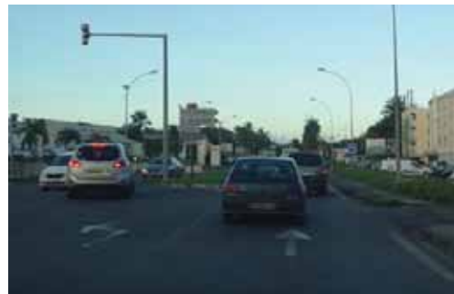
N5 - entre Pointe-à-Pitre et Le Gosier – voie de configuration routière
