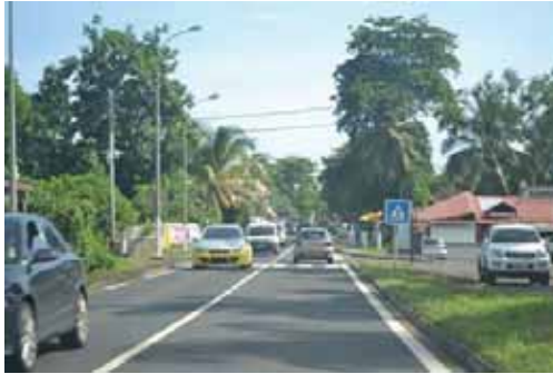
N1 – Goyave – absence de trottoirs
