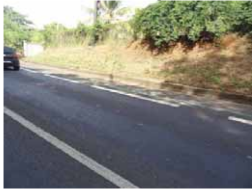
N1 - Entre Baie Mahault et Goyave : des sections étroites de bandes multifonctionnelles ou bandes cyclables
