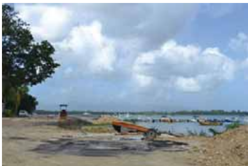
Aménagement du front de mer de Baie-Mahault
