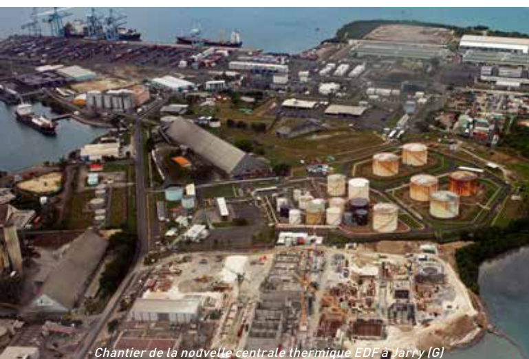
Chantier de la nouvelle centrale thermique EDF à Jarry (G)
