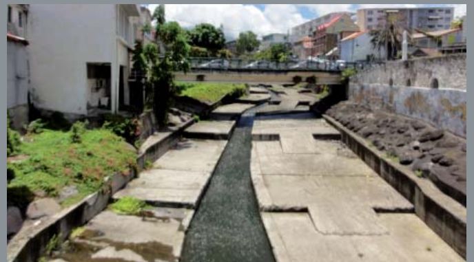
écoulement canalisé à Basse-Terre
