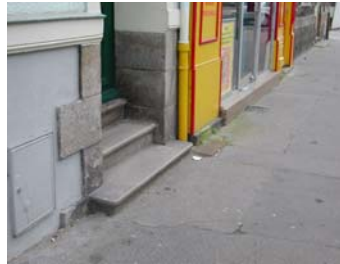
7 : Différents accès aux bâtiments
