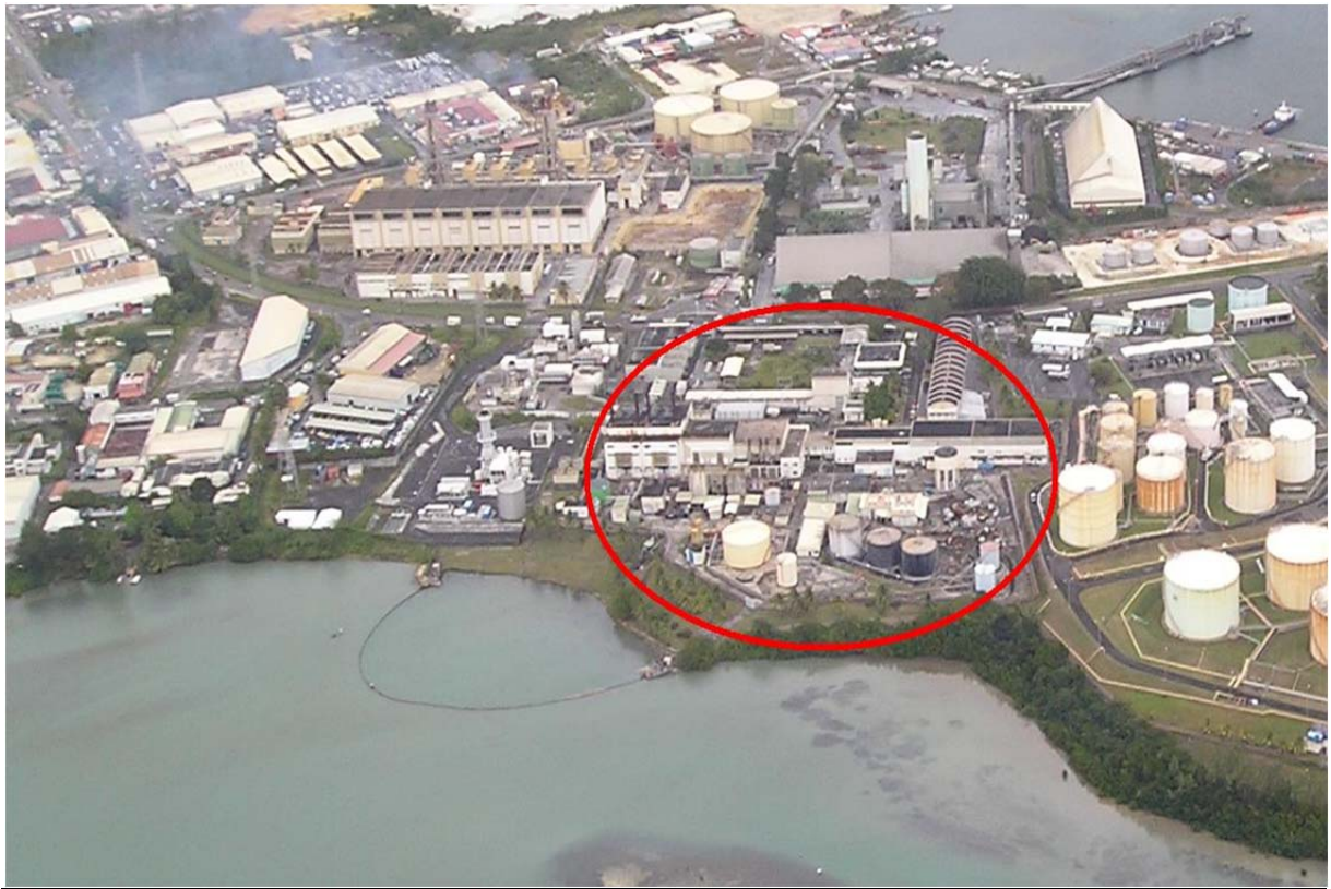
Images du site : vue aérienne de la centrale électrique EDF de la Pointe Jarry
