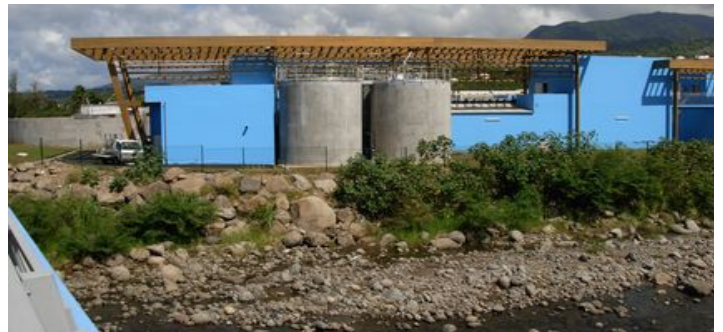
Nouvelle station d'épuration de Baillif (CASBT)
