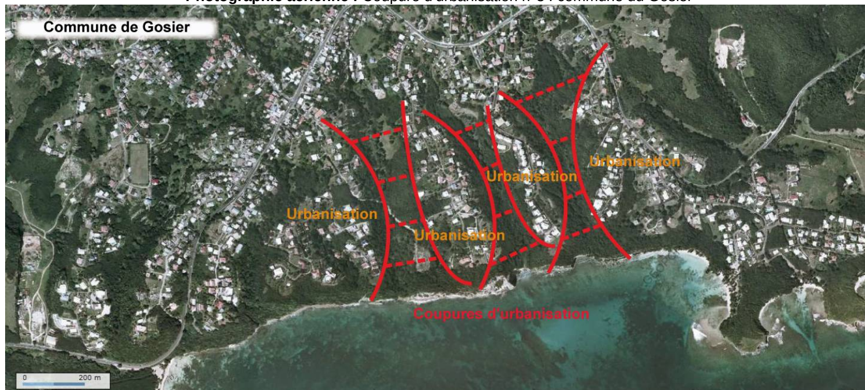
Photographie aérienne : Coupure d'urbanisation n°3 : commune du Gosier
