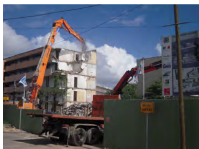
Démolition de la barre AE de la cité Henri IV
