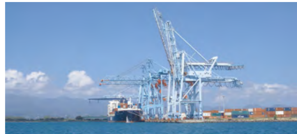
Port autonome de la Guadeloupe - Baie Mahault
