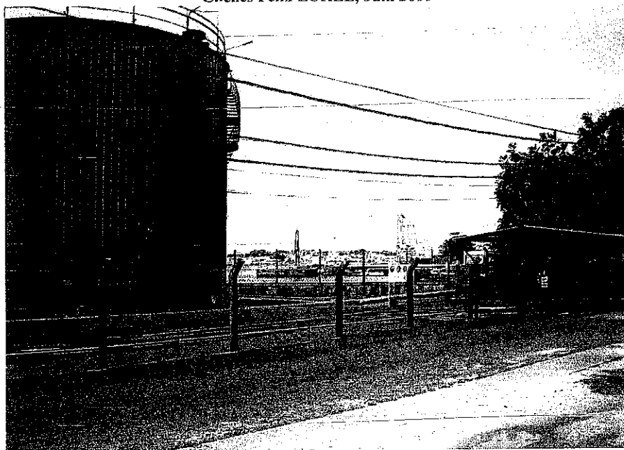
Vue sur quai 10 et zone portuaire
