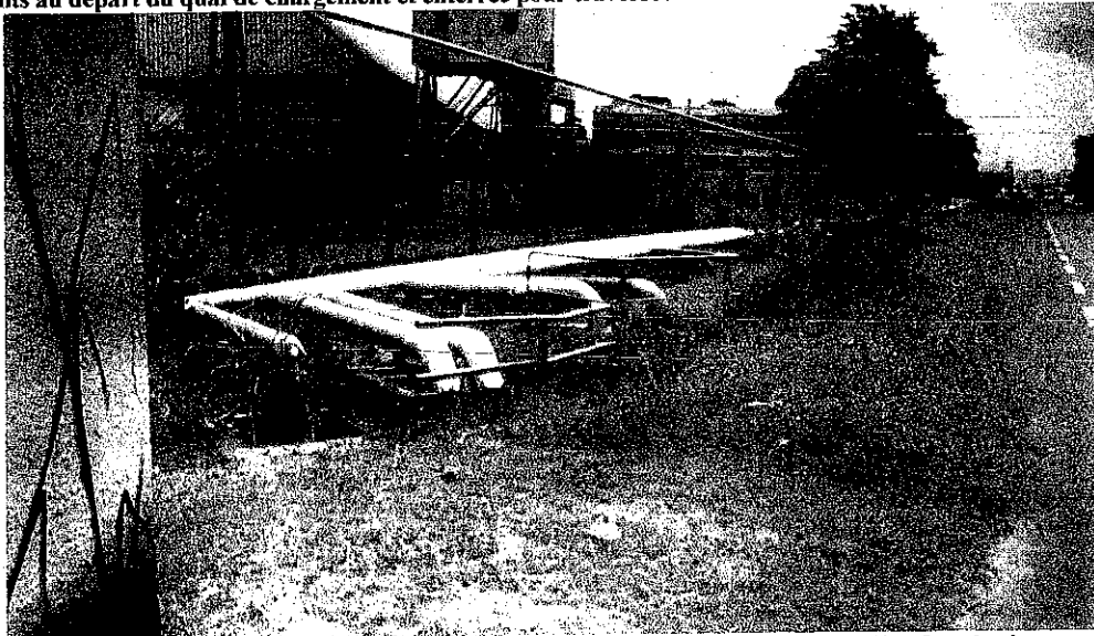
Tuyauterie de différentes couleurs à mieux protéger, par renforcement du radier dans le virage
