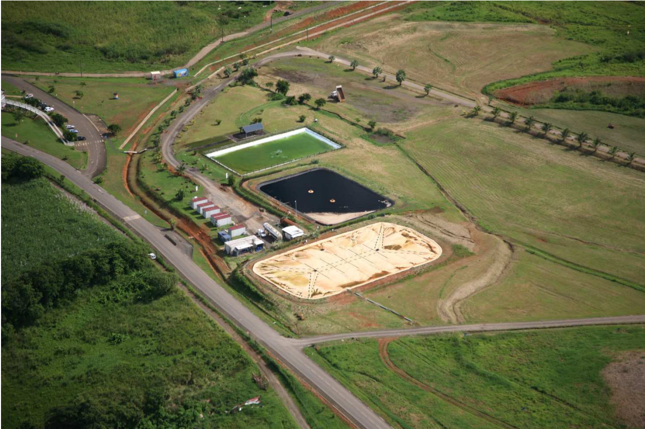
Figure 41. Vue d'ensemble de l'installation de traitement des lixiviats et ses bassins de prétraitement et stockage
