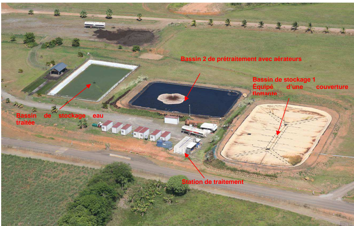
Figure 18. Vue aérienne de l'ensemble des installations de traitement des lixiviats
