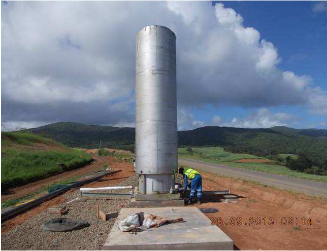
Figure 47. Mise en place de la torchère BG 1 000
