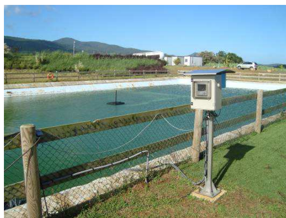
Figure 38. Appareil de contrôle en continu bassin eaux osmosées.
