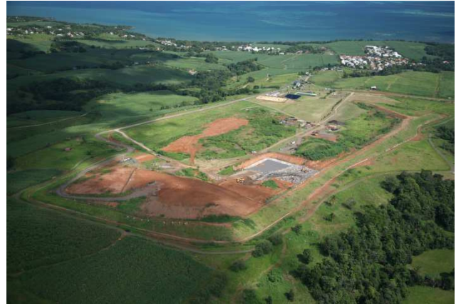
Figure 33. Vue générale sud (12/14)
