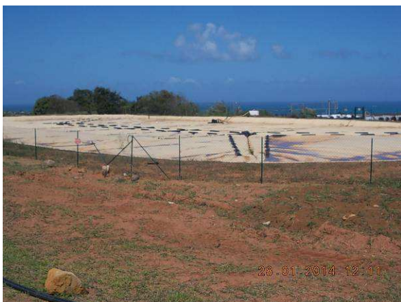
Figure 39. Couverture du bassin de lixiviat 1
