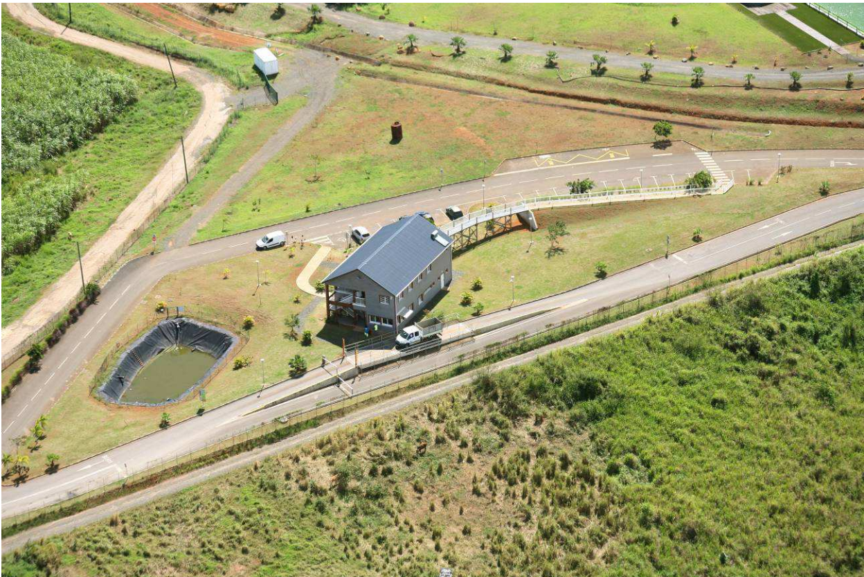
Figure 34. Vue d'ensemble de la zone frontale du site
