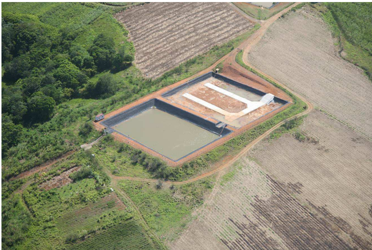
Figure 44. Vue aérienne des bassins de rétention avec le bassin ER1 équipé de rampe pour le curage de matière de décantation.
