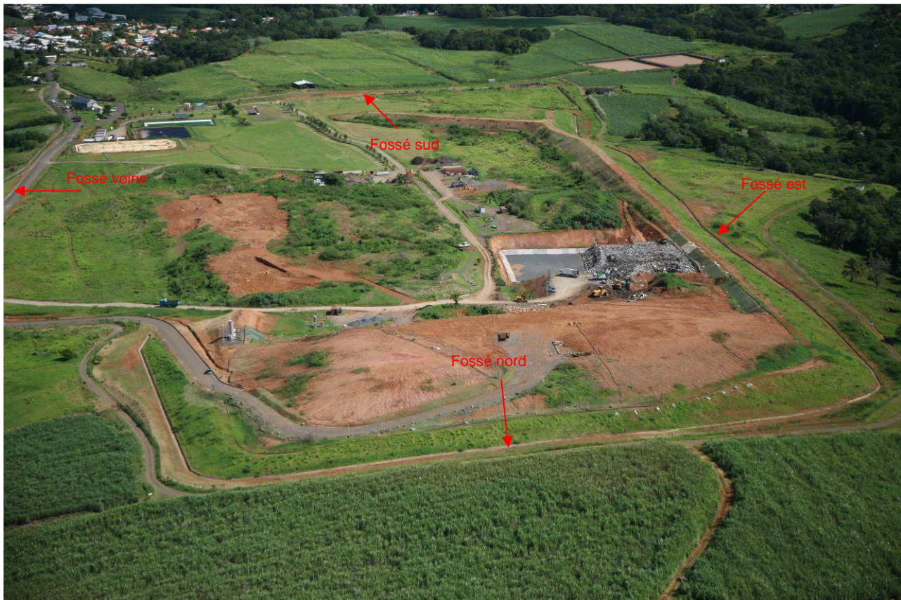
Figure 45. Vue des fossés béton de pied de digue extérieur
