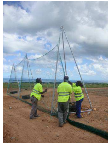
Figure 26. Mise en place de filet de protection anti-envols en périphérie de la zone de stockage
