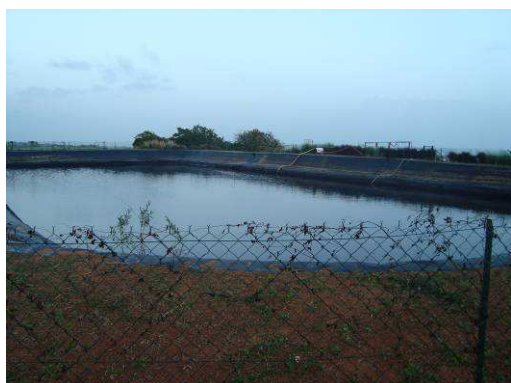
Figure 35. Bassin de stockage des lixiviats 1 avant couverture
