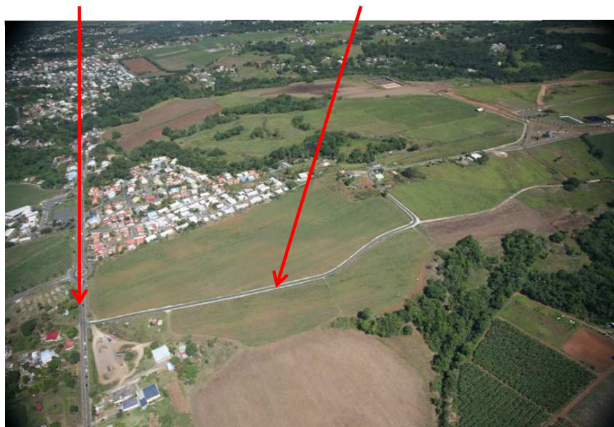
Figure 28. Vue aérienne de la voirie d'accès externe
