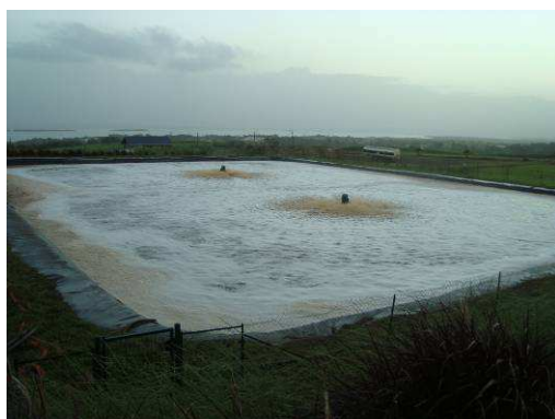
Figure 36. Vue du bassin 2 (aérateurs)
