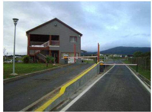
Figure 12. Vue d'ensemble du pont bascule et ses aménagements
