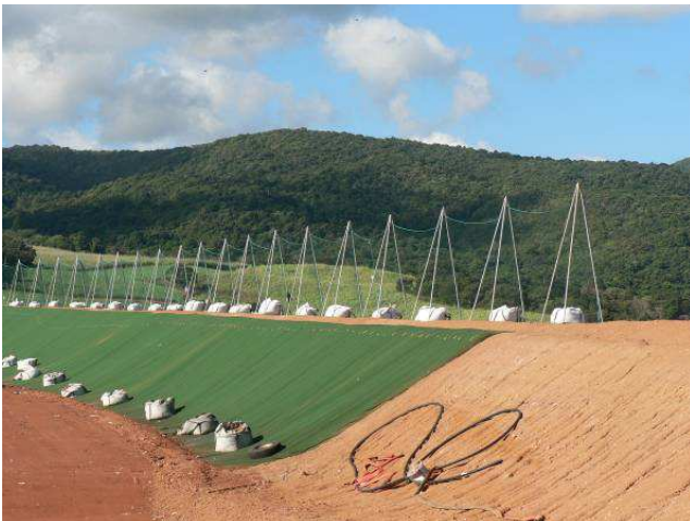
Figure 26. Mise en place de filet de protection anti-envols en périphérie de la zone de stockage
