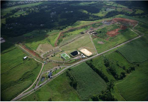
Figure 32. Vue générale nord (12/14)
