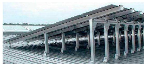
Figure VI.10 : Exemple de montage des modules sur structure inclinée - www.archiexpo.fr
