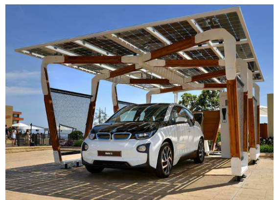
Figure VI.15 : Abri photovoltaïque pour voiture - source : BMW
