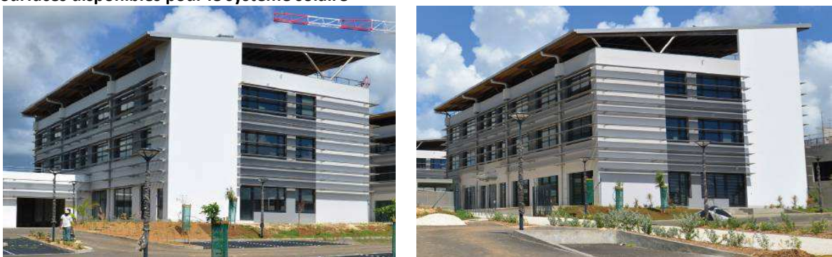
Figure V.9 : Vue des bâtiments F et G de la DEAL et la DAAF - source DEAL/COLORADO
