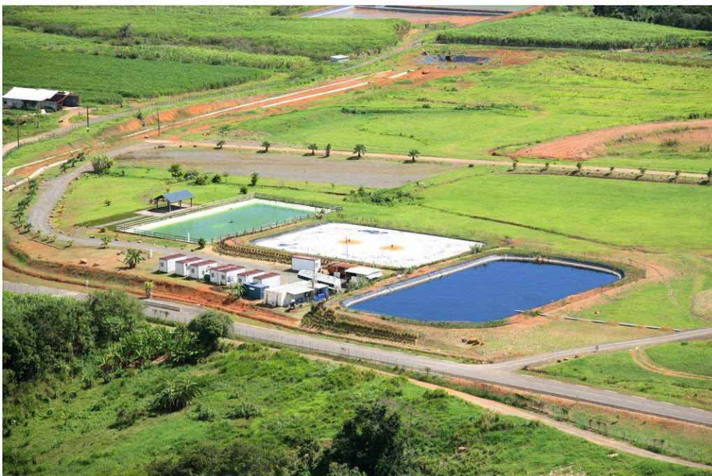
**Figure 40. Vue d'ensemble de l'installation de traitement des lixiviats et ses bassins de prétraitement et stockage**
