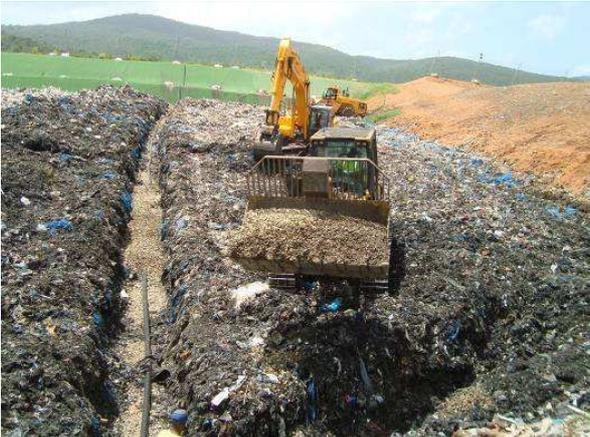
**Figure 50. Réalisation artères pour un meilleur captage du biogaz.**
