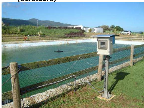
**Figure 37.** Appareil de contrôle en continu bassin eaux osmosées.
