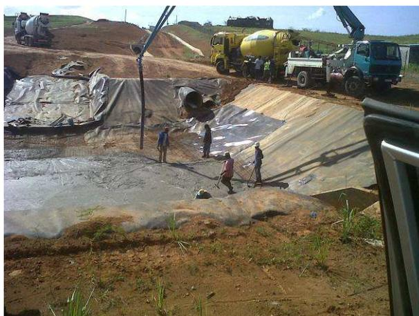
**Figure 42. Béton dans le bassin de décantation.**
