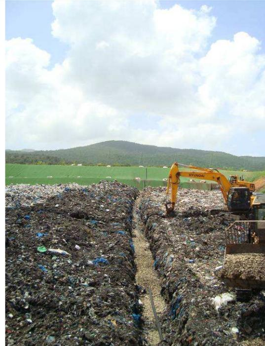
**Figure 51. Mise en place d'un drain biogaz dans l'alvéole A2 (4/10/11)**
