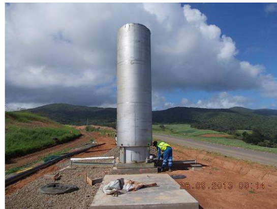
Figure 50. Mise en place e la future torchère BG 1000
