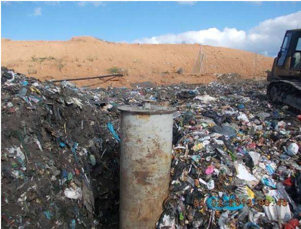
Figure 49. Réalisation artères pour un meilleur captage du biogaz.
