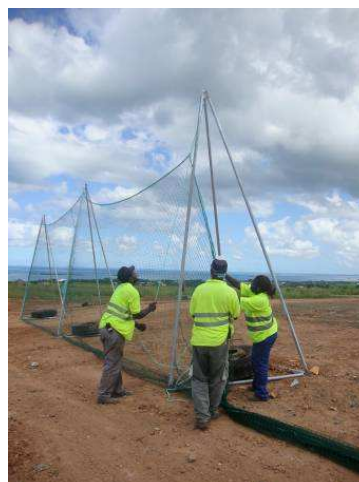
Figure 23. Vues de la mise en place des filets de protection anti-envols en périphérie de la zone de stockage
