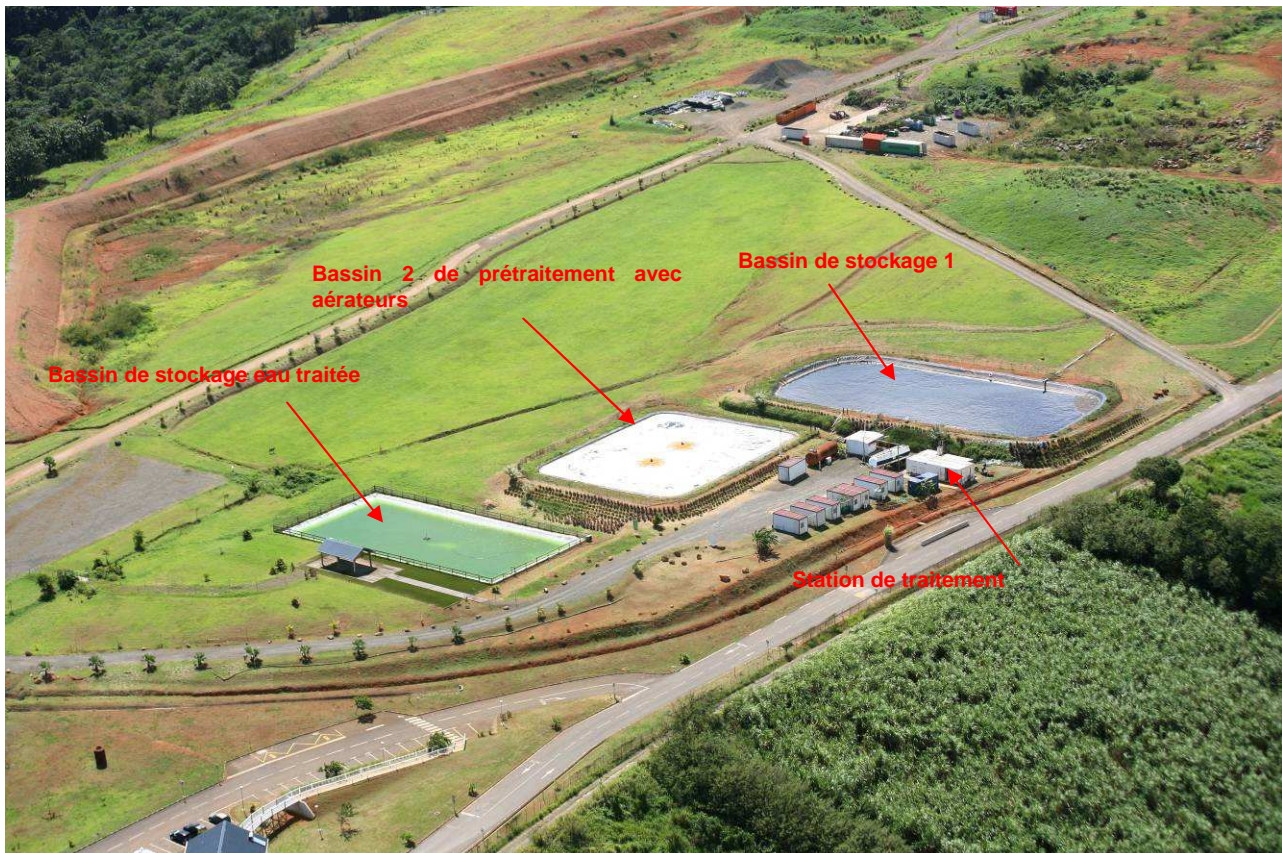
Figure 28. Vue aérienne de l'ensemble des installations de traitement des lixiviats
