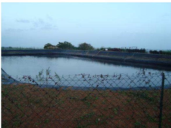
Figure 35. Bassin de stockage des lixiviats 1 avant couverture
