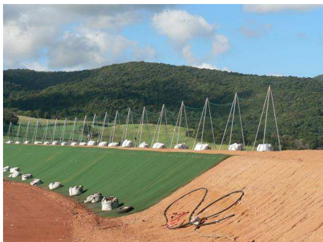
Figure 23. Vues de la mise en place des filets de protection anti-envols en périphérie de la zone de stockage
