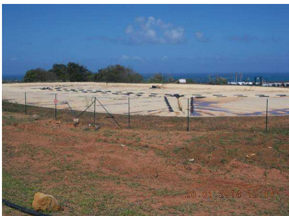
Figure 39. Couverture du bassin de lixiviat 1
