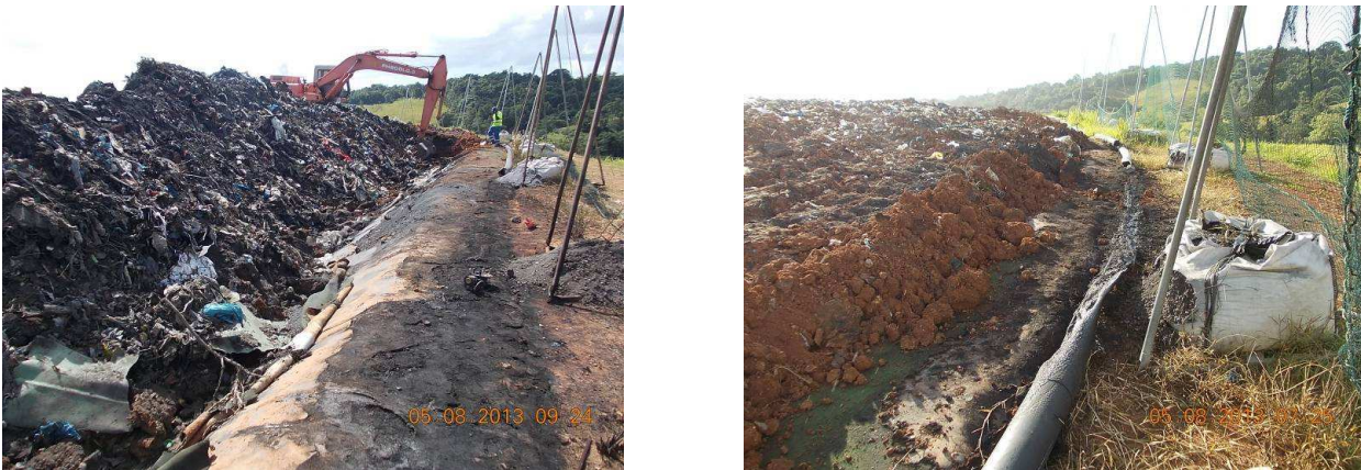
Figure 29. Vues des dommages occasionnés suite au départ de feu du 03/08/13
