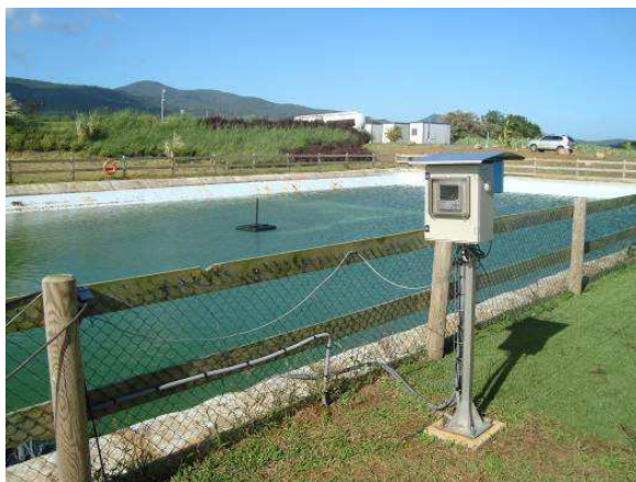
Figure 38. Appareil de contrôle en continu bassin eaux osmosées.
