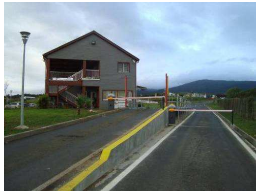
Figure 13. Vue d'ensemble du pont bascule et de ses aménagements
