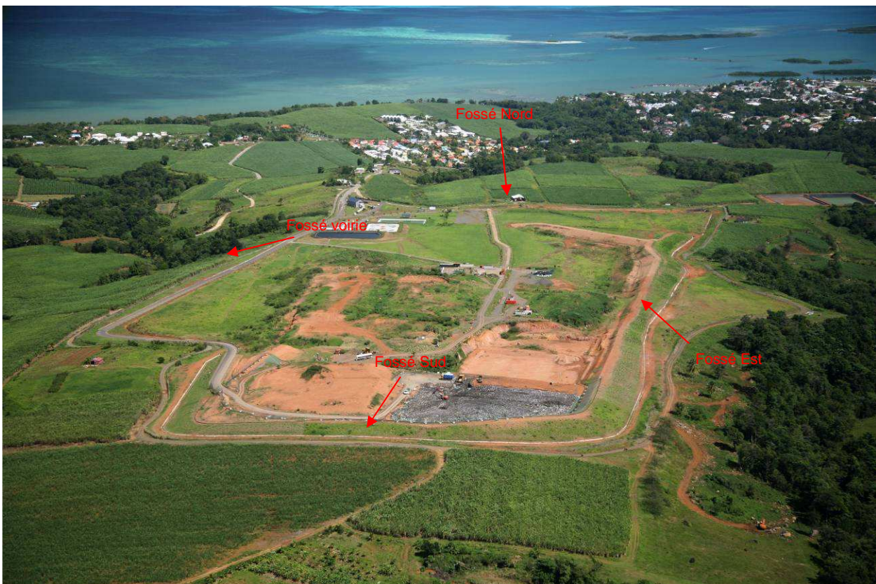
Figure 45. Vue des fossés béton de pied de digue extérieure
