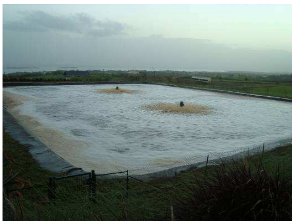
Figure 36. Vue du bassin 2 (aérateurs)
