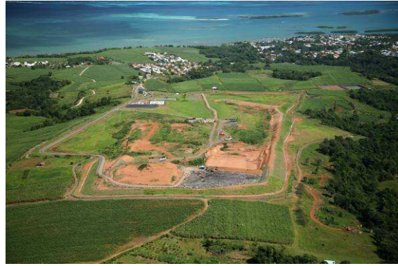
Figure 33. Vue générale sud (01/13)
