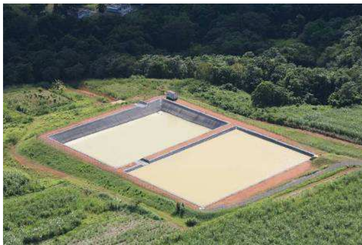
Figure 44. Vue aérienne des bassins de rétention
