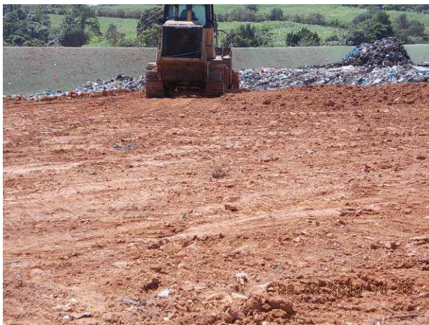
Figure 17 - Aménagement de la couverture provisoire
