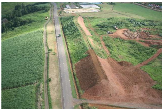
Figure 19 - Vue de la digue périphérique nord (décembre 2015)
