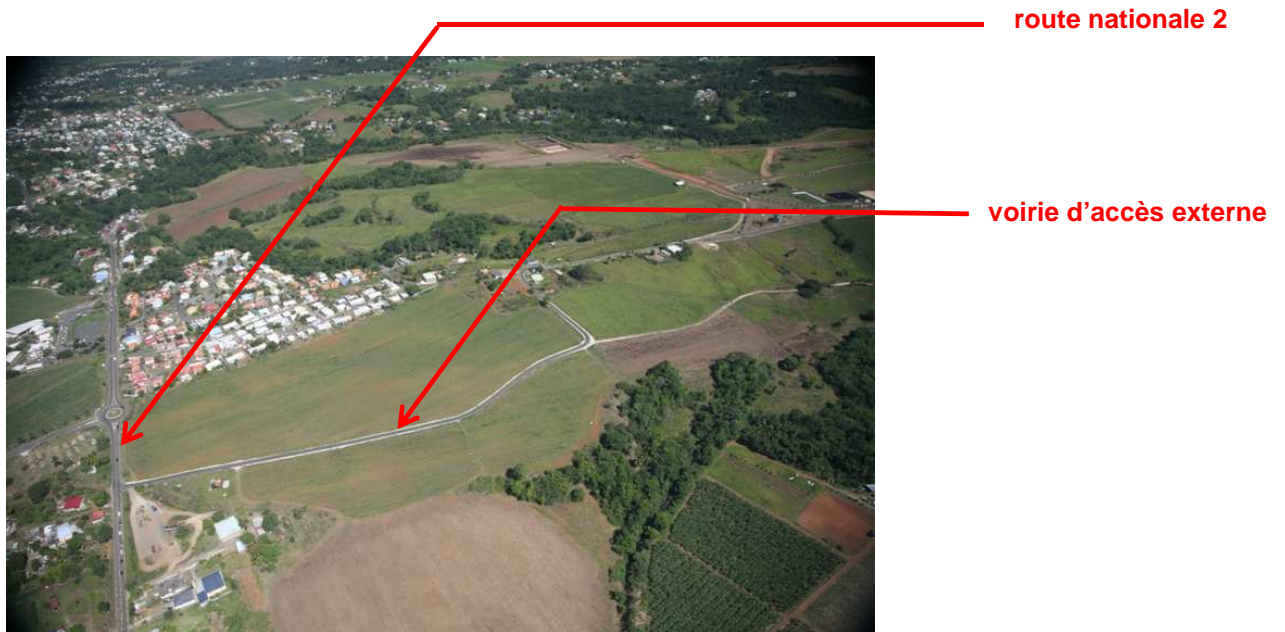
Figure 13 - Vue aérienne de la voirie d'accès externe
