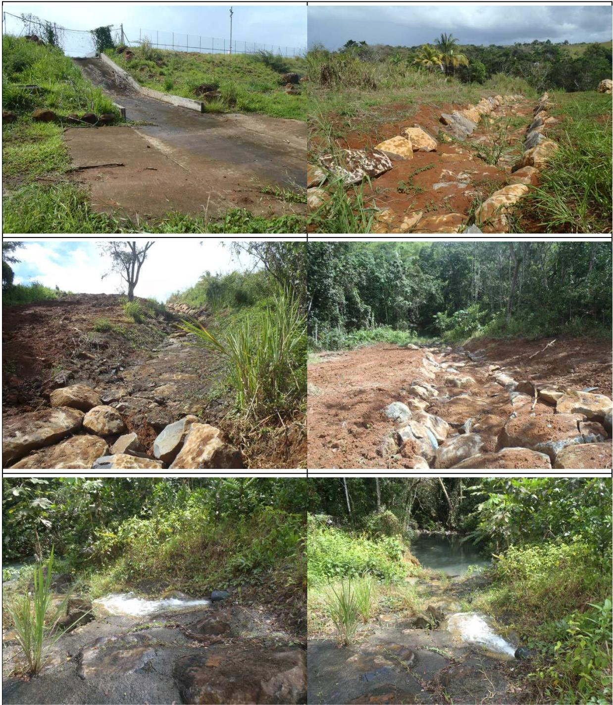
Figure 5 : Zone de surverse du bassin de décantation, chenal jusqu'au lit de la rivière et rejet actif du CSDND le 14 avril 2015.
