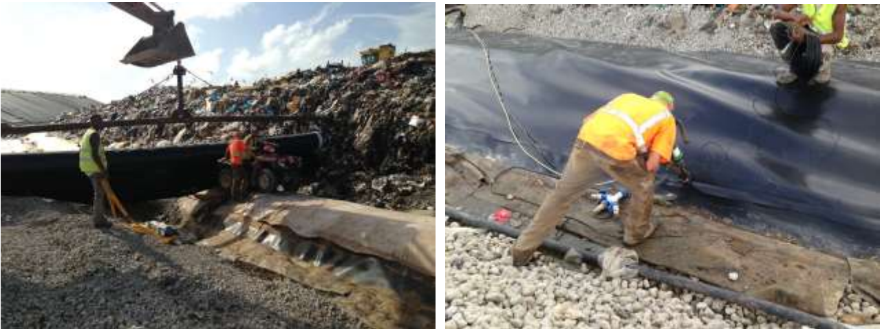
Figure 25: Réparations suite à l'incendie du 14/07/2013
