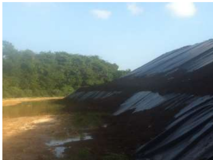
Figure 23: Glissement des terres sur le talus Ouest
