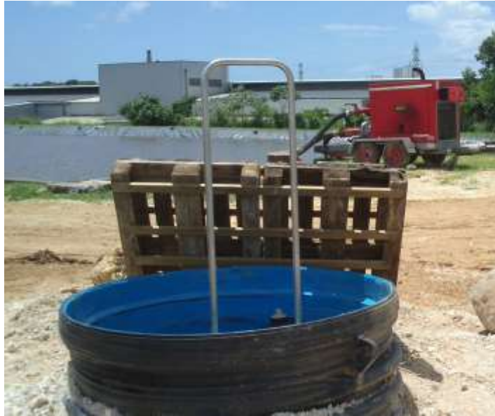
Figure 15: Chambre de pompage n°1
