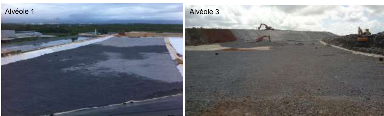
Figure 12: Mise en place des cailloux drainants des alvéoles 1 et 3
