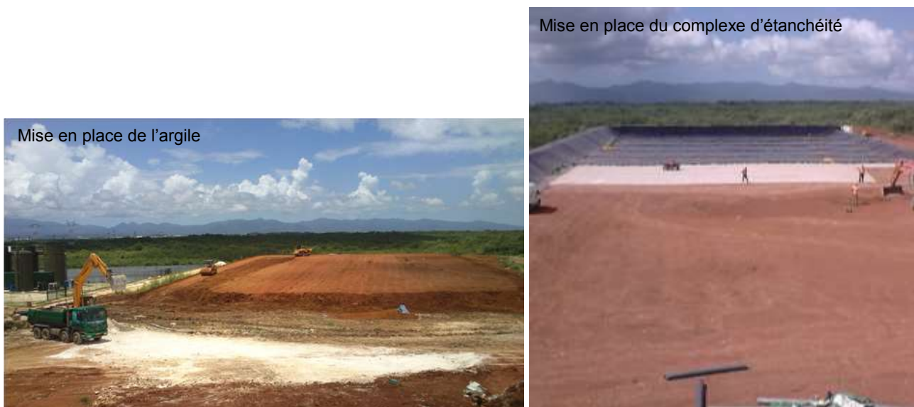
Figure 13: Construction de l'alvéole 2
