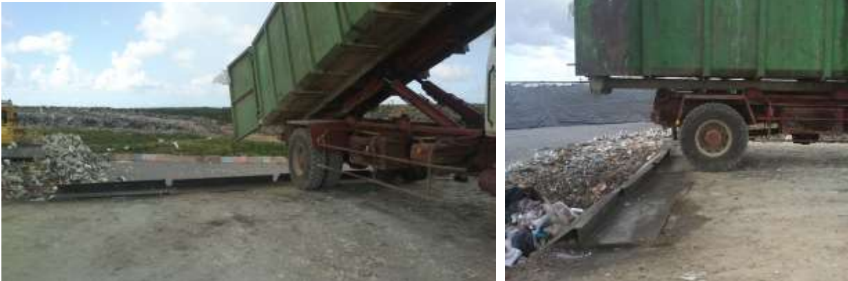
Figure 16: Quai de déchargement au droit de l'alvéole 1
