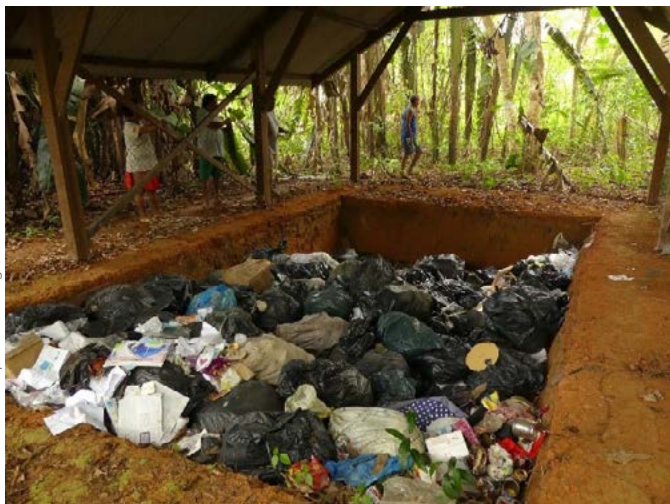
Eco-carbet de Kalana pour le stockage des déchets
