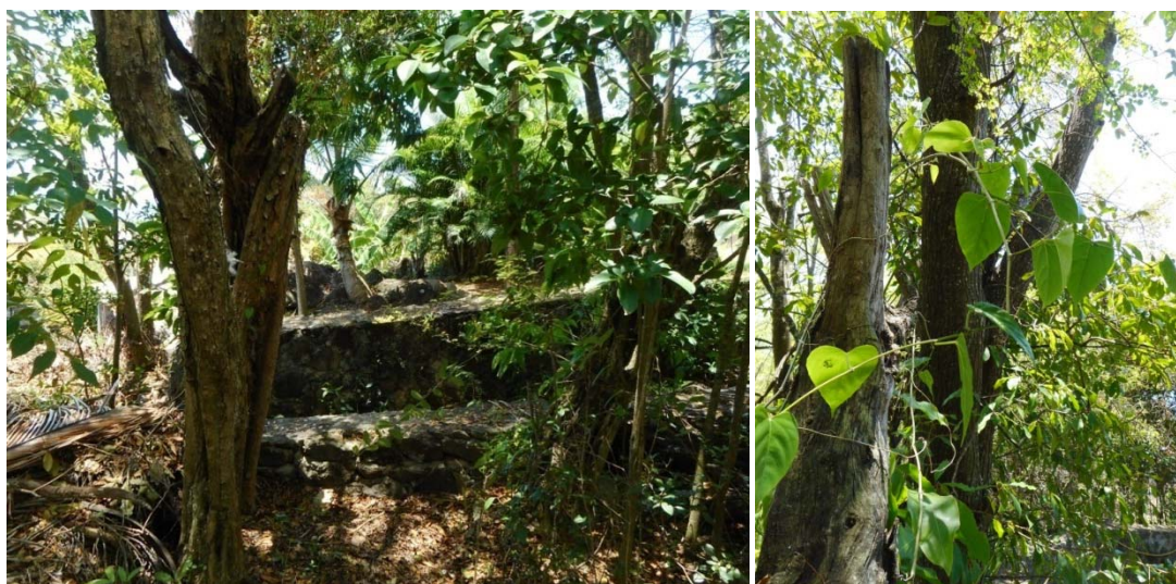
Figure 30 : Végétation du canal
