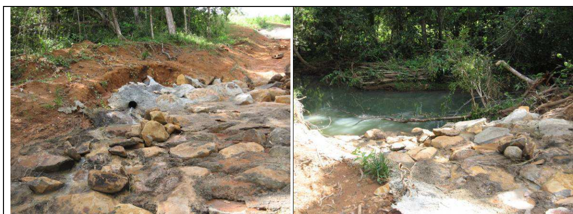
Figure 4 : Rejet du CSDND en rive gauche de la rivière Salée au niveau d'une mouille. Coordonnées GPS du rejet : 638 030 – 1 804 851. Rejet fonctionnant en continu à 0,25m 3 /s.
