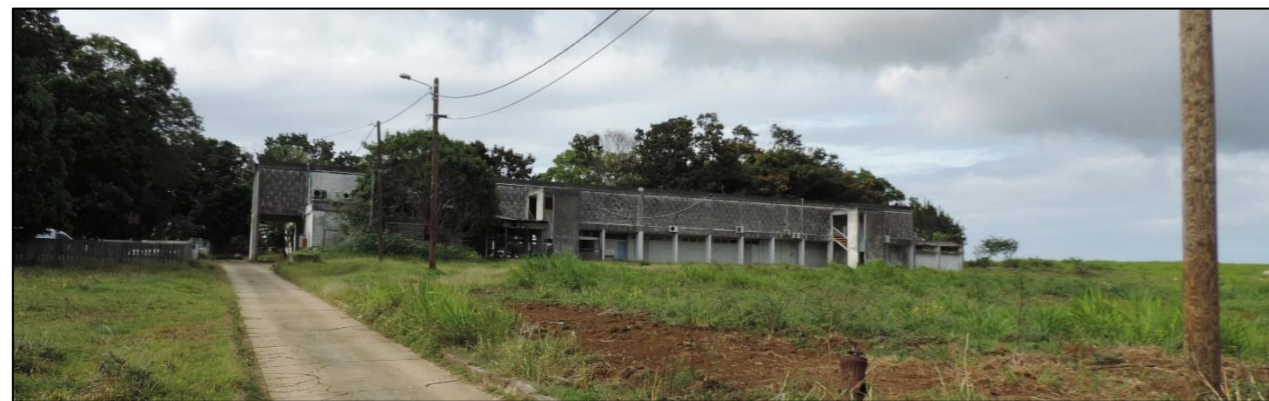
Figure 16 : Ancien lycée agricole qui domine le site. (Source : ANC Concept)
