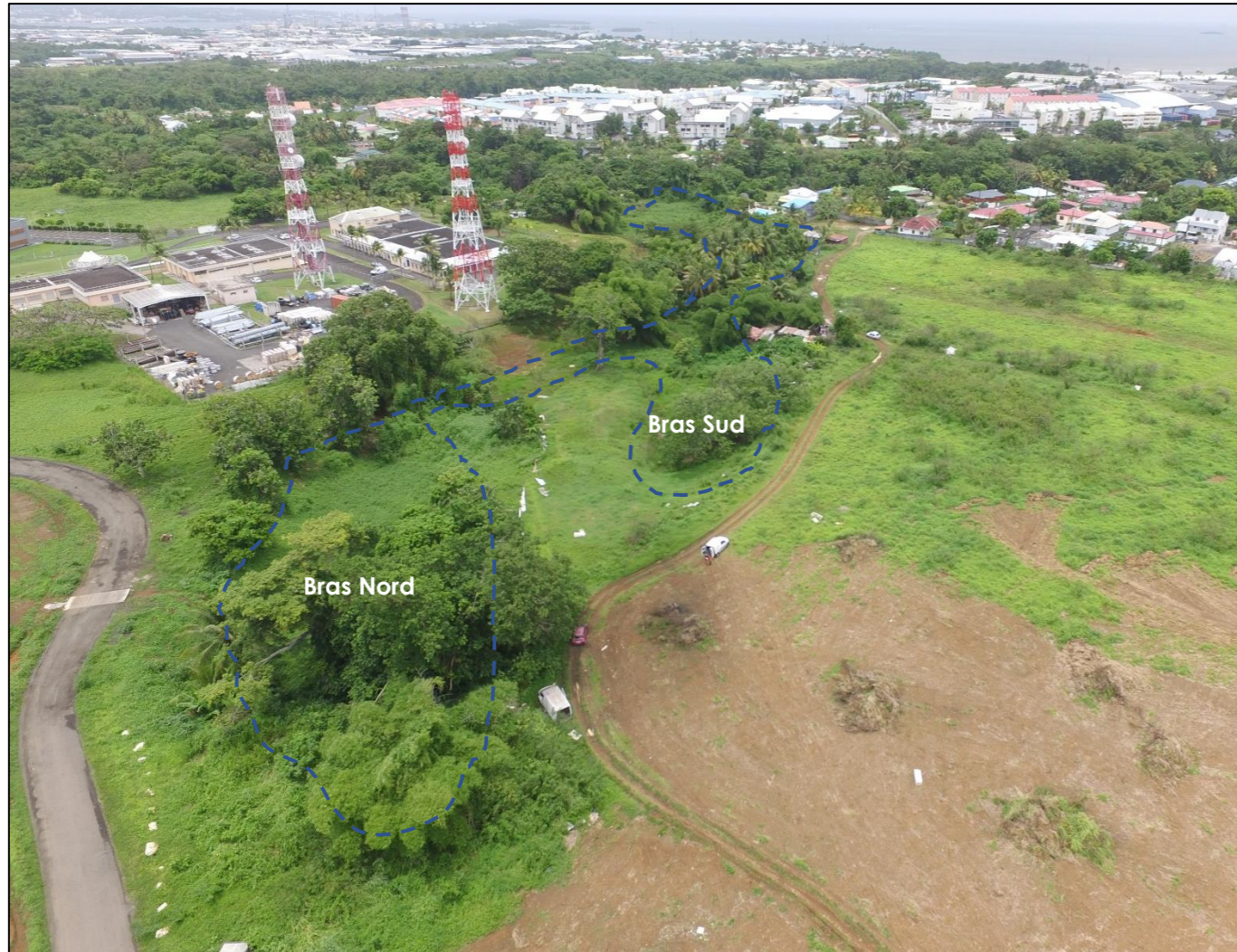
Figure 19 : Vue aérienne de la ravine. (Source : ANC Concept)
