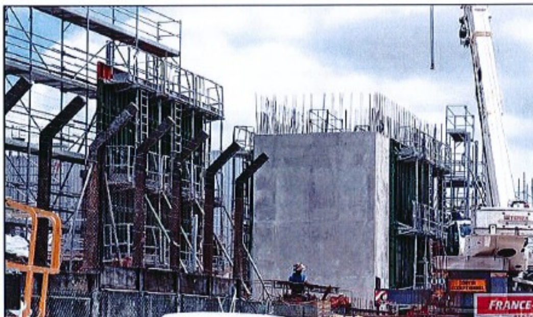
TRAVAUX. Un travail est mené dans les nouvelles constructions en terme de ventilation, ceci pour éviter le plus possible l'utilisation d'climatiseurs. EDF archipel Guadeloupe se veut un modèle de maîtrise de la consommation énergétique. (Roberto Brehus)
