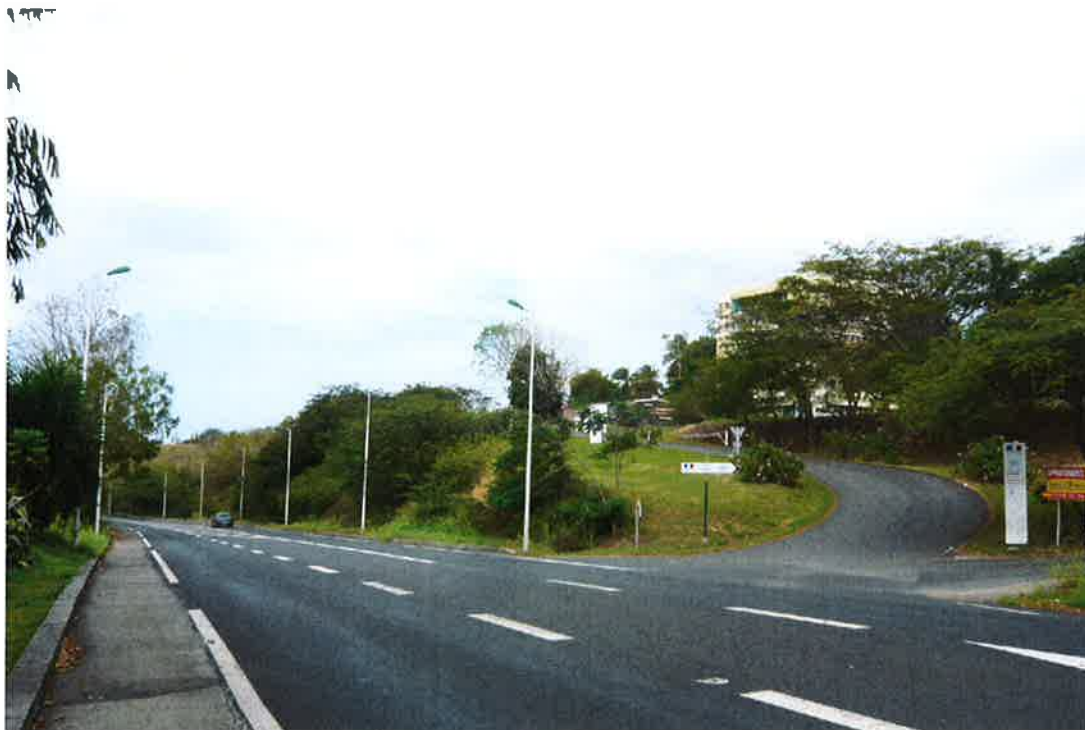
Vue 2 : Vue de l'accès Sud du terrain
