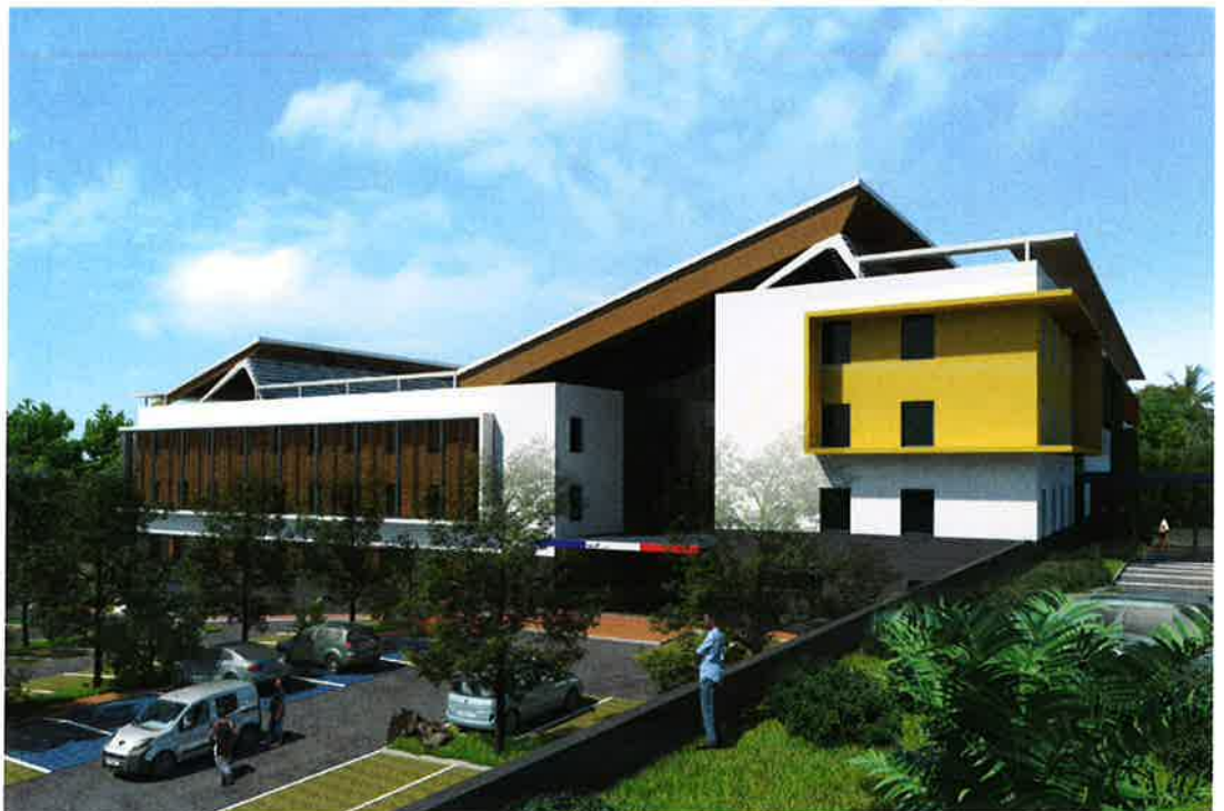
Vue 4 - Vue de l'entrée du projet
