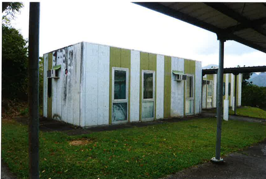
Photographie du préfabriqué
