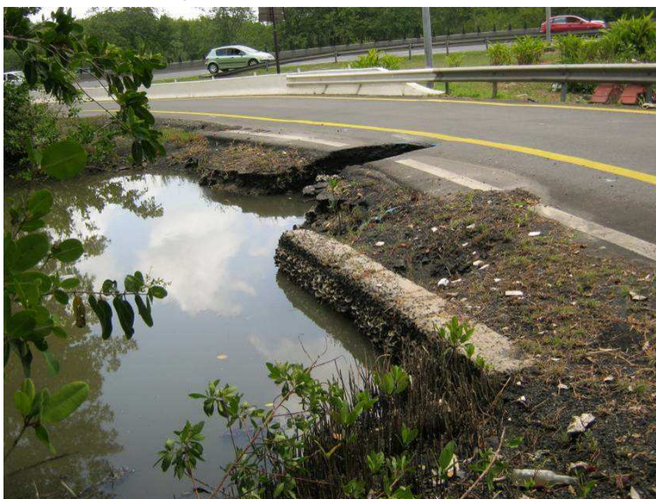
Figure 10 : Vue aval de l'ouvrage vers le canal de la Plaine et effondrement de la chaussée
