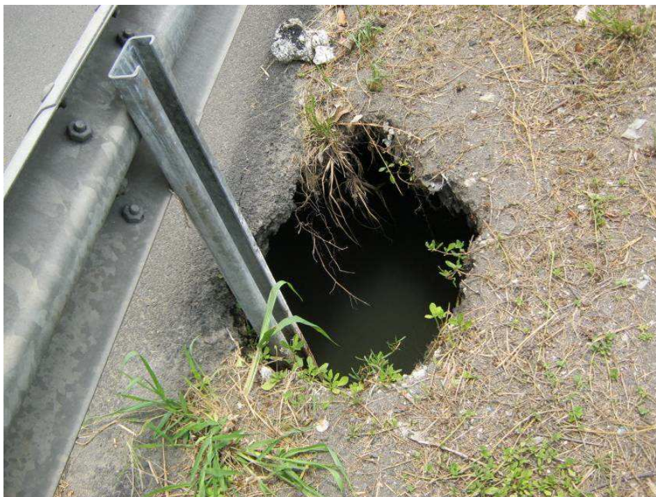
Figure 11 : Affouillement de la chaussée
