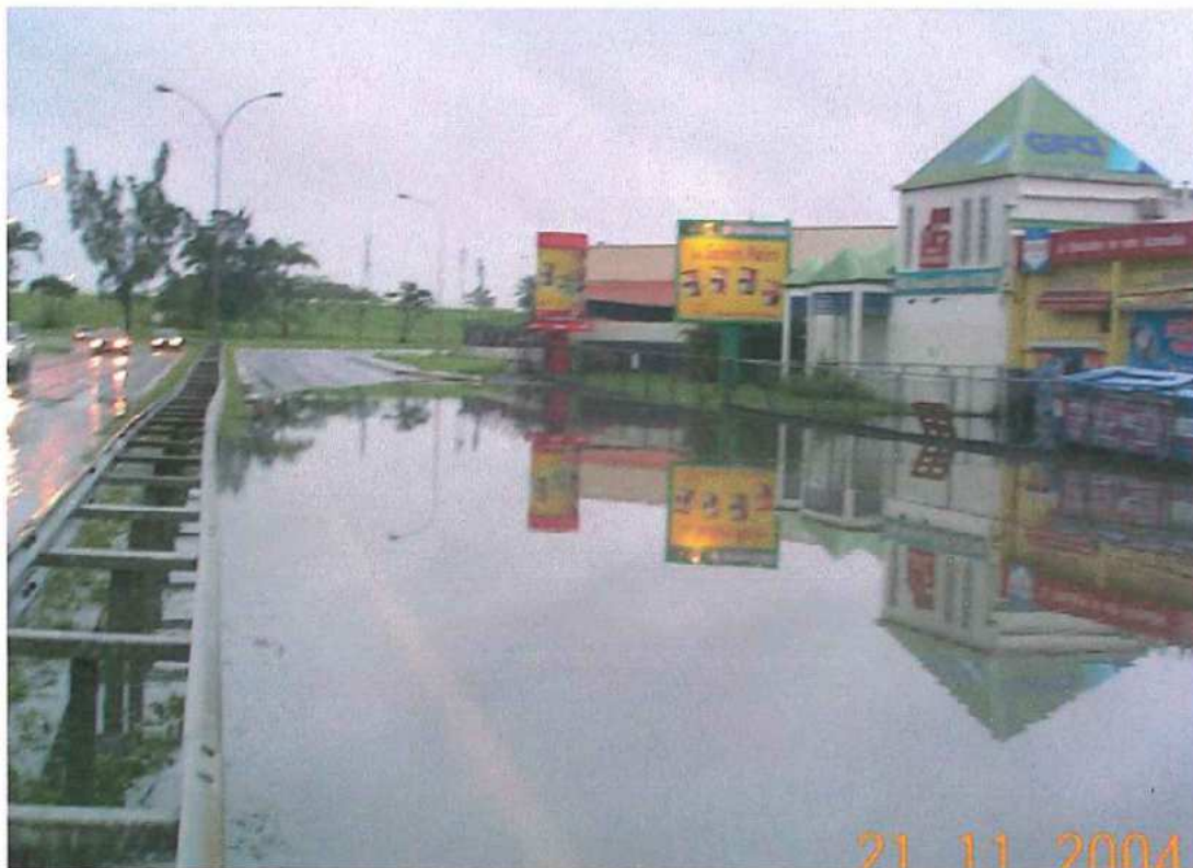
Figure 17 : Inondation du 21 novembre 2004- vue de la RD126 vers le Rond-point de Grand-Camp (source : Réseau d'assainissement pluvial Grand-Camp Ouest, étude hydraulique, Subdivision de l'équipement de Pointe-à -Pitre, Ville des Abymes, 2004)
