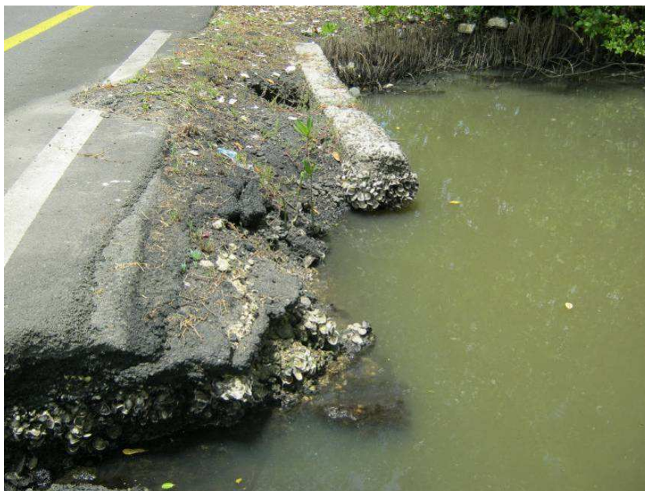
Figure 12 : Différentes couches de rechargement en enrobé de la bretelle de sortie
