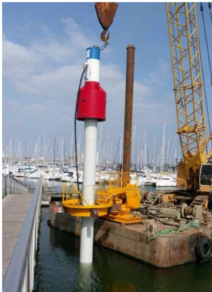
Figure 18 : illustration d'une opération de battage de pieux via un module nautique (source http://www.pajot.com )
