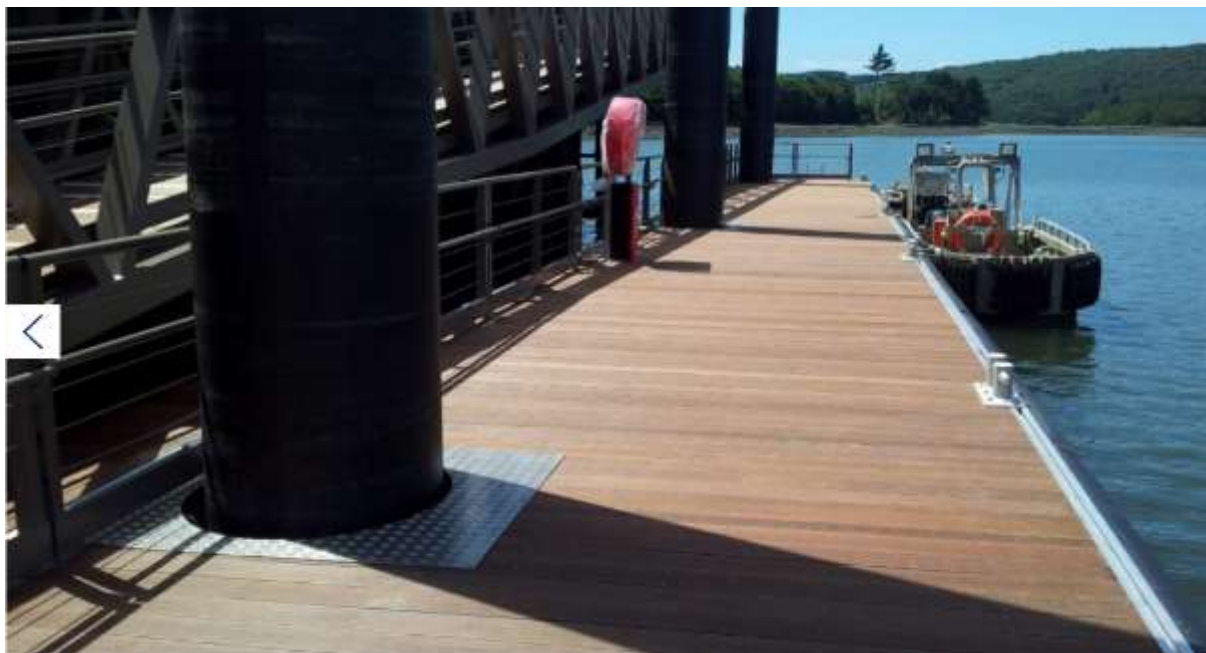
Figure 17 : illustration d'un ponton flottant similaire à ceux qui seront mise en œuvre sur le site de Fouillole (source : http://atlanticmarine.fr ).
