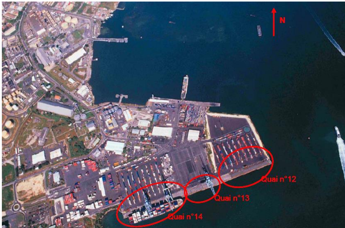
Figure 7 : Localisation du quai 13 sur les terrains du GPMG côté Jarry
