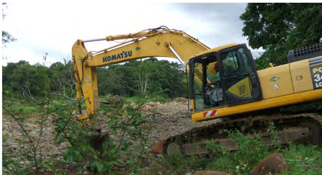
Rivière Bras David à Petit-Bourg – travaux de curage depuis la berge
