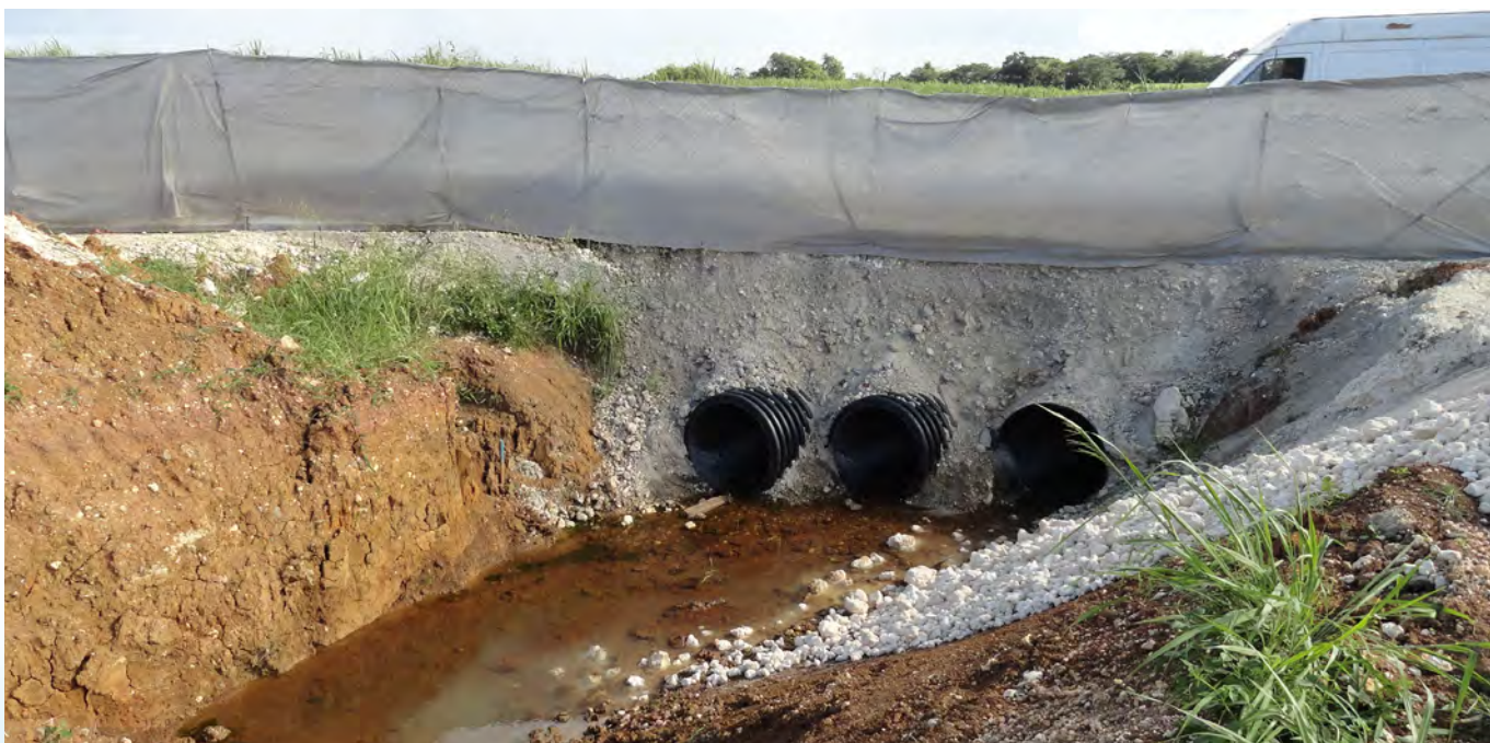
Ravine Lolo à Sainte-Rose – utilisation de tuf (proscrite) pour la création d'une piste d'accès provisoire
