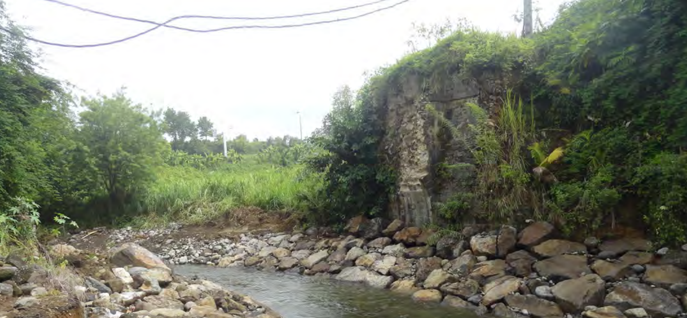
Rivière du Grand Carbet à Capesterre Belle-Eau – travaux de protection de berges
