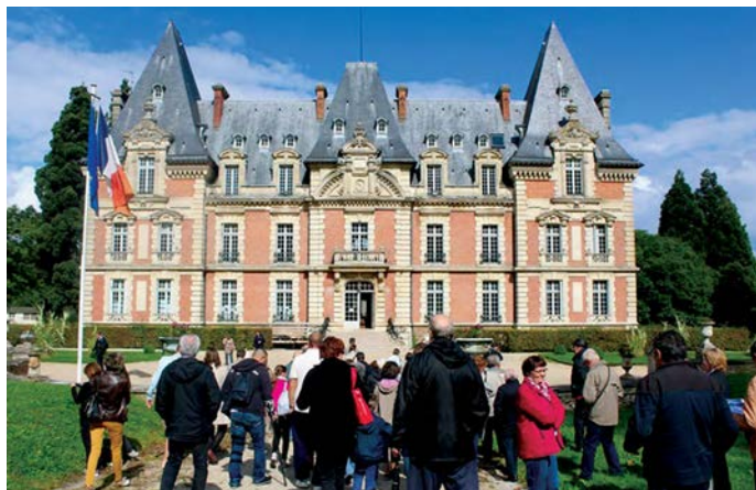
Château de la Haute Maison de Montry – Centre EPIDE Montry, Seine-et-Marne © Eric Defer
