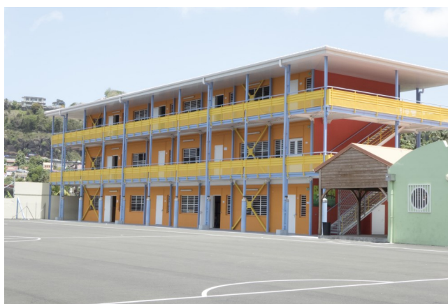
Exemple de confortement parasismique, quartier Trénelle, Fort-de-France
