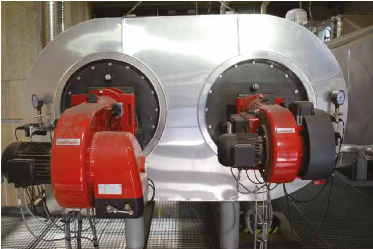
Unité de digestion de la station d'épuration de la Communauté Urbaine de Cherbourg
