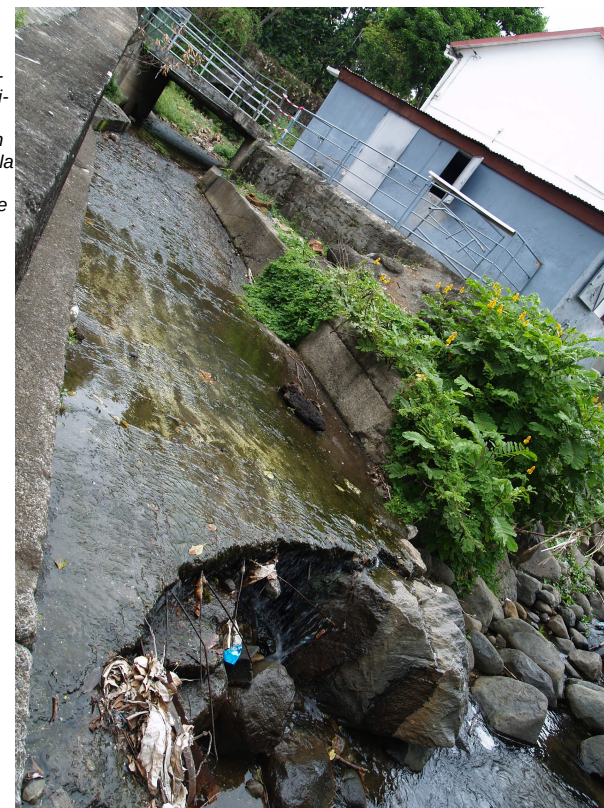
Canalisation de la ravine du lion
