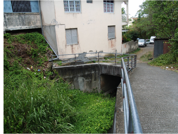
ouverture et canalisation du canal lepeltier
