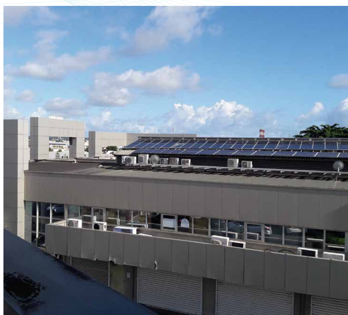
Toiture bâtiment tertiaire
