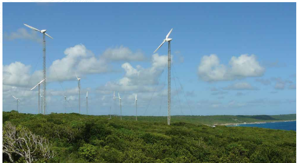
Parc éolien en Guadeloupe
