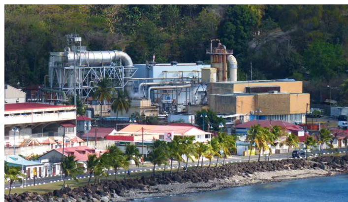
Centrale géothermie Bouillante
