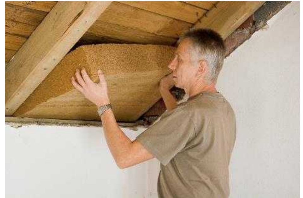
Isolation entre chevrons et contre ossature métallique (ou contre chevron)
