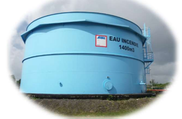
Sablage peinture du bac incendie
