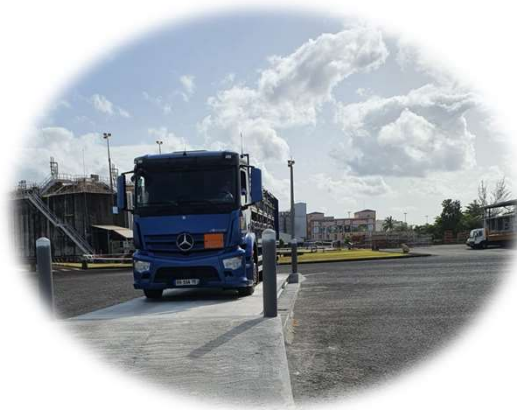
Installation du pont bascule
