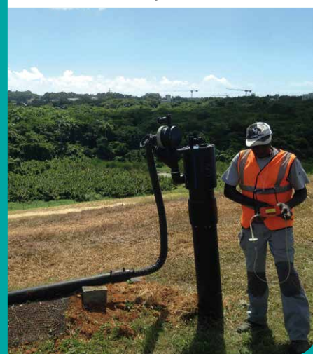
Récupération du biogaz sur l'ISDND de la Gabarre, Les Abymes
