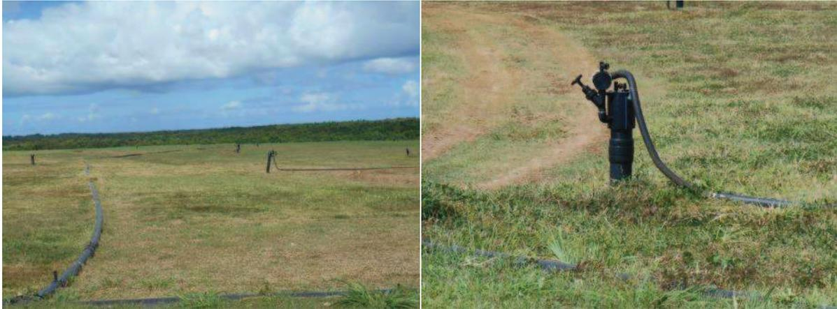
Figure 7 : Puits de dégazage mis en œuvre sur le dôme
