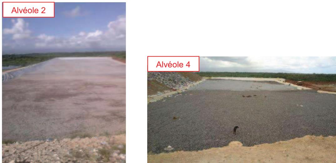
Figure 14 : Mise en place des cailloux drainants au droit des alvéoles 2 et 4
