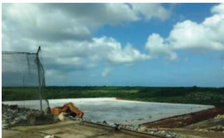
Figure 15 : Mise en place du géosynthétique bentonitique de l'alvéole 6
