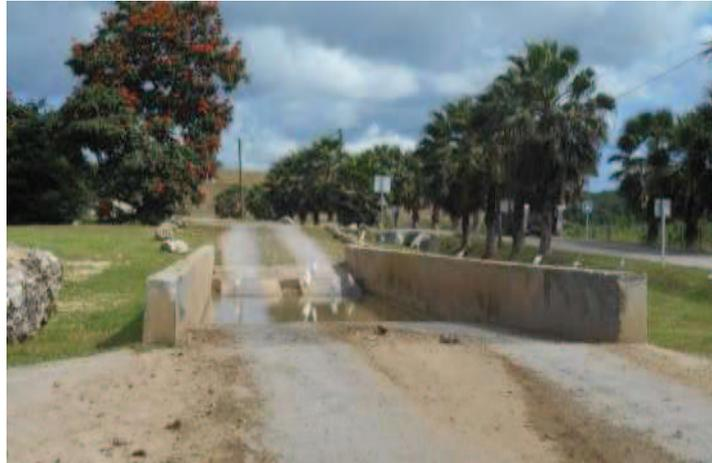
Figure 20 : Lave-roues de l'ISDND de la Gabarre
